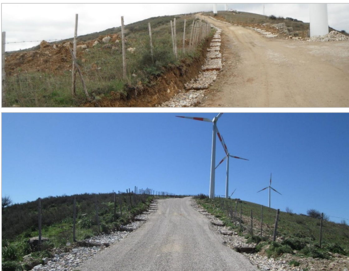
Figura 3.1 Esempi di sistemi di fossi di guardia con fondo rivestito in pietrame e salti.
