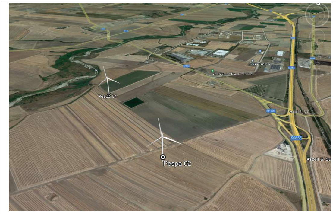
Fig. 9 Vista 3D su Google bearth con aerogeneratori di altezza veritiera
