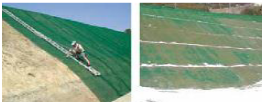
Fig. 19 - Esempio realizzativi con geostuoia
