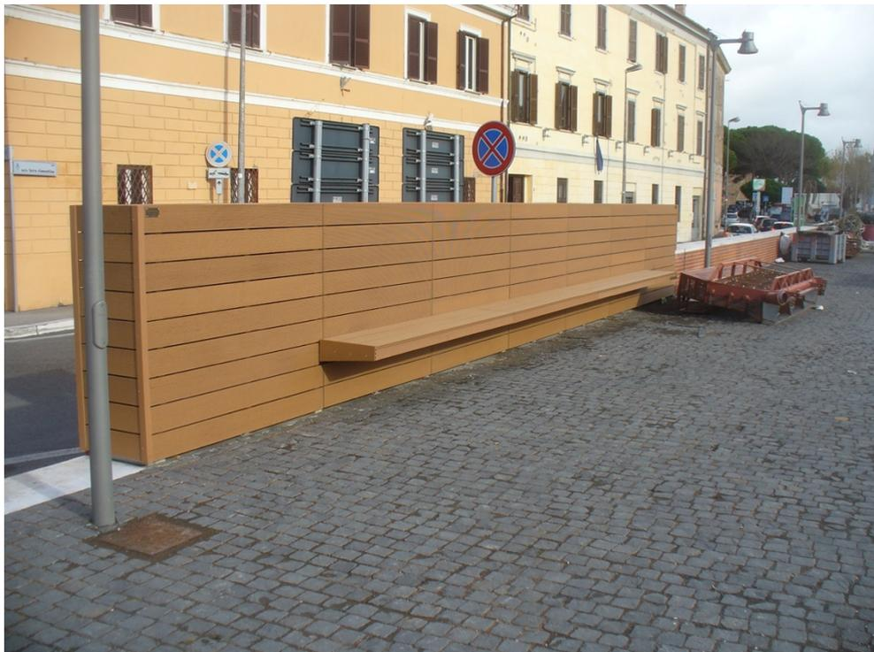
**Figura 21.** Banchina sponda destra – Armadio per alloggiamento paratie scorrevoli – Vista da ovest.
