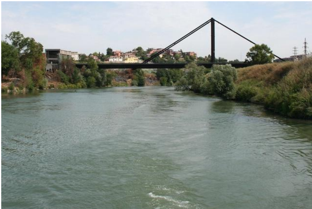
* Il ponte tubo de La Magliana 2 vista da valle ricognizione del 25_03_2013
