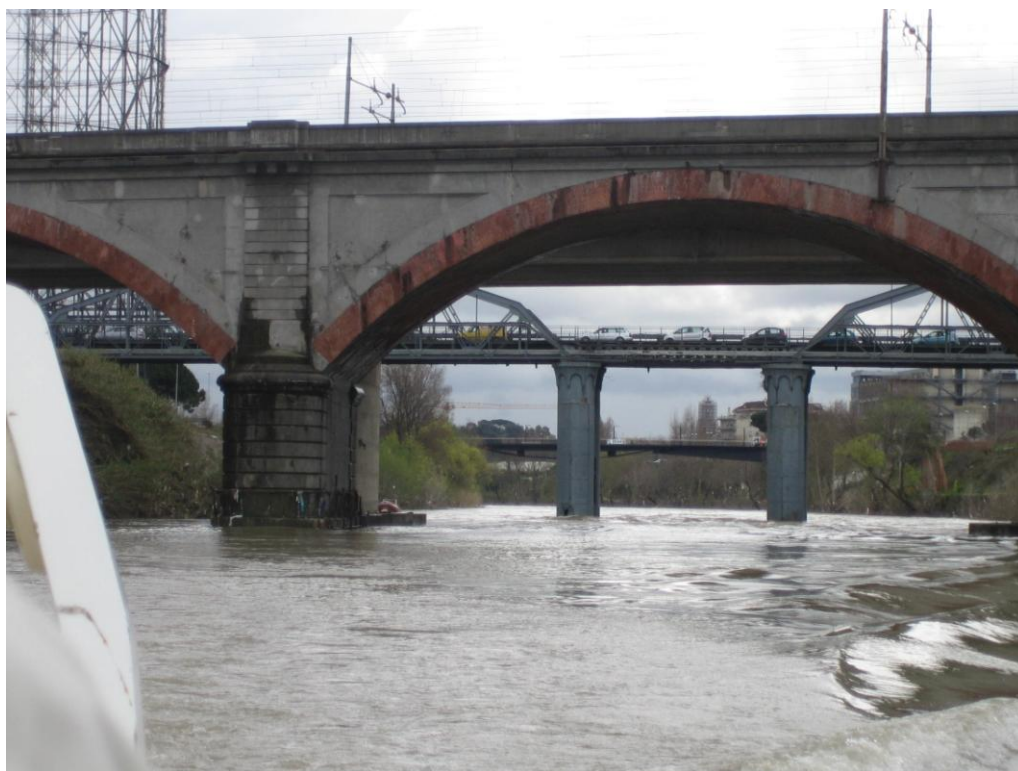
* Ponte ferroviario vista da valle ricognizione del 25_03_2013
