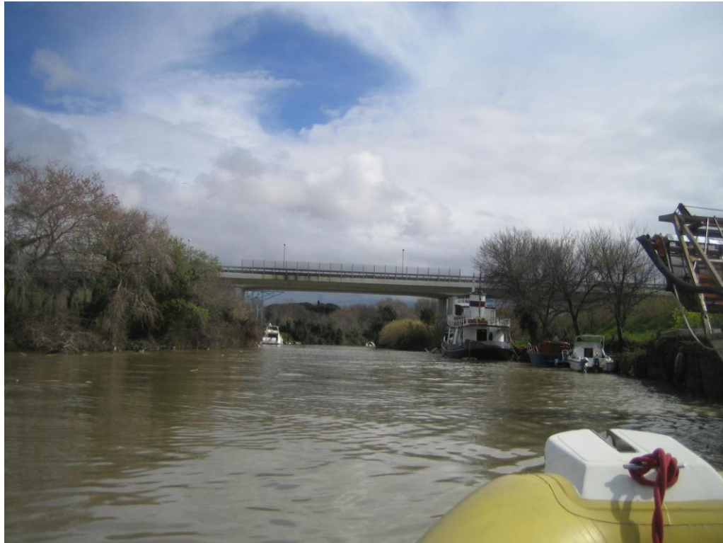
*Ponte della SS 296 sul canale Fiumicino vista da valle ricognizione del 25_03_2013
