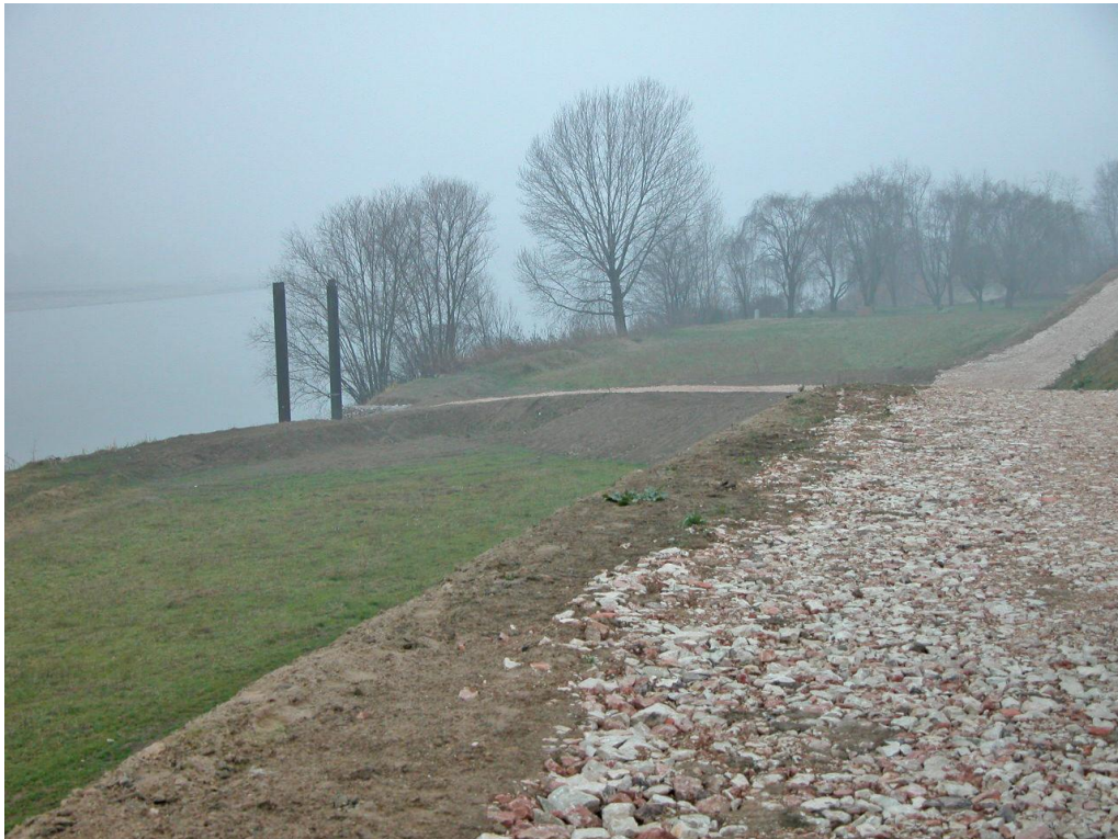
*intersezione di rampe di accesso al pontile.
