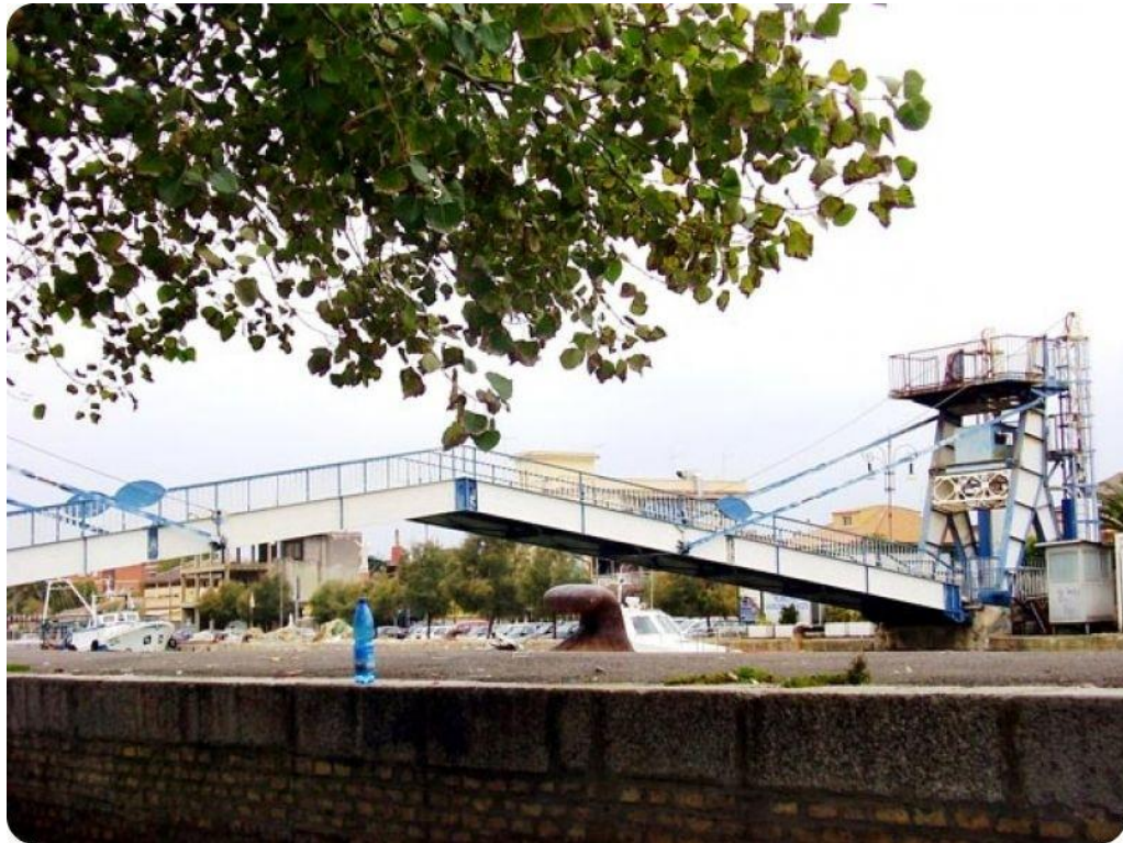
* Passerella in acciaio pedonale canale Fiumicino vista da valle ricognizione del 25_03_2013
