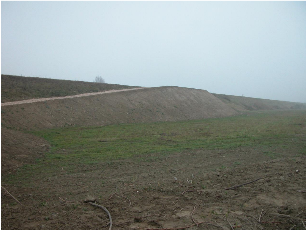
* rampe d collegamento sommità arginale / accesso al pontile.
