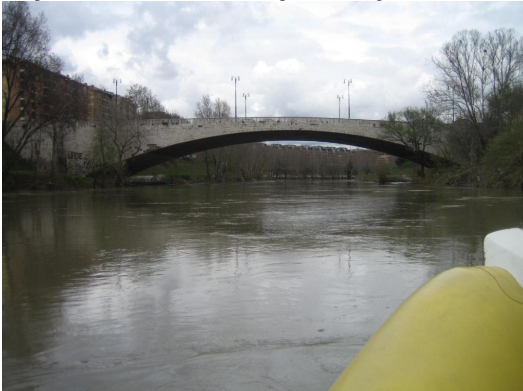
* Ponte Testaccio vista da valle ricognizione del 25_03_2013
