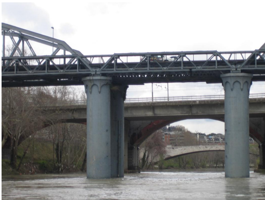
* Ponte dell'Industria vista da valle ricognizione del 25_03_2013
