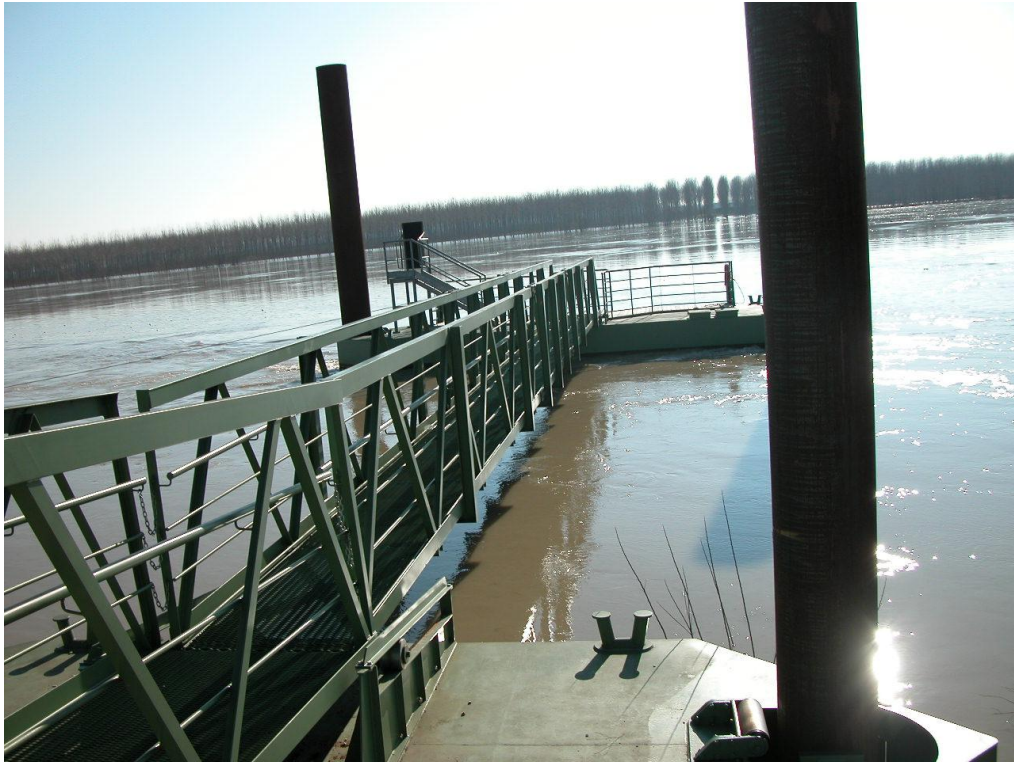
* particolare dei vincoli fra piattaforma di terra e piattaforma in alveo, vista d'insieme.
