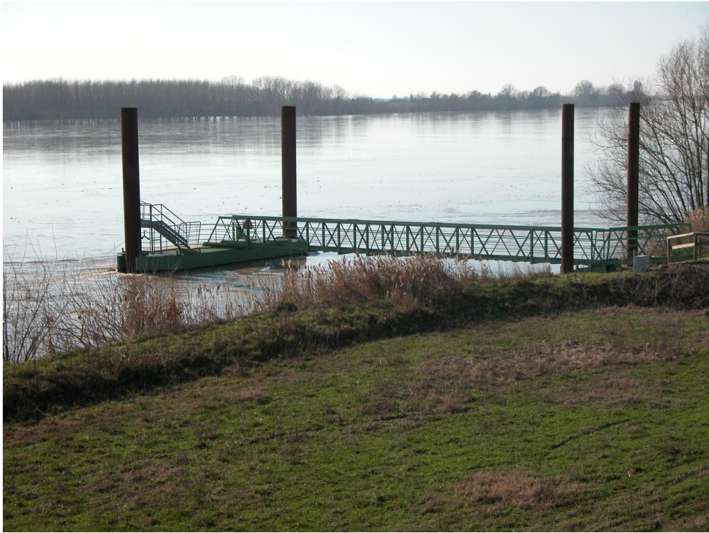
* posizionamento orizzontale della passerella in condizioni di piena.
