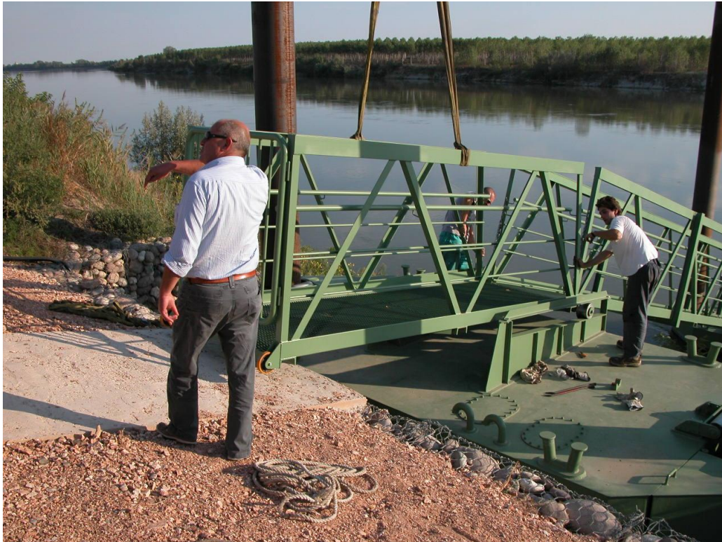
* particolare del collegamento della passerella di terra.
