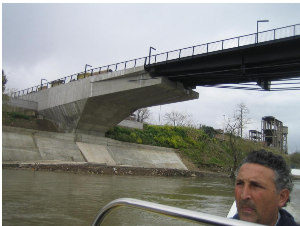
* Ponte della scienza vista da monte ricognizione del 25_03_2013
