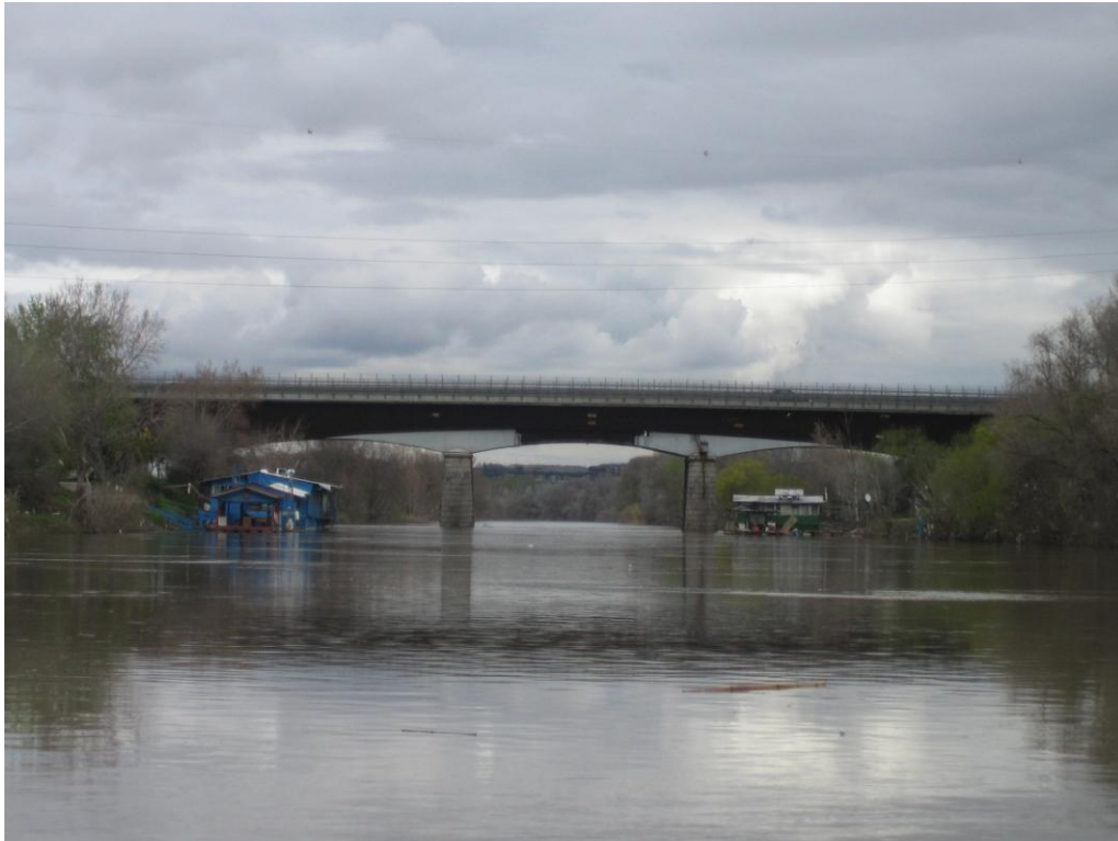
*Ponte Mezzocammino vista da valle ricognizione del 25_03_2013
