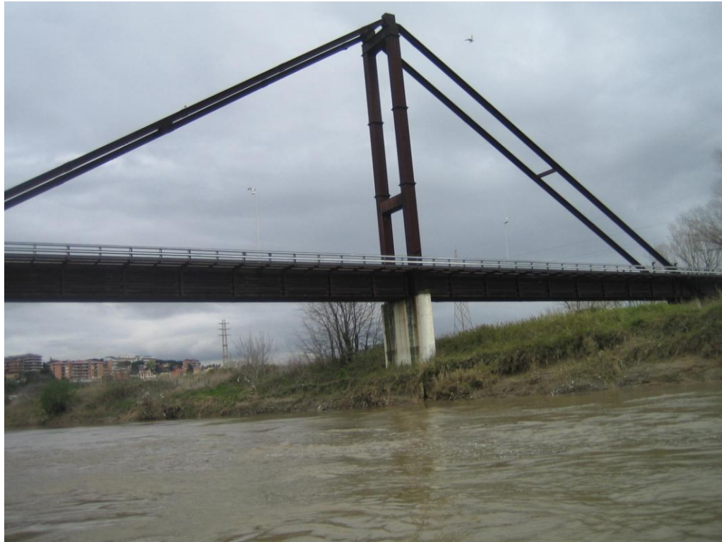
* Il ponte tubo de La Magliana 1 vista da valle ricognizione del 25_03_2013
