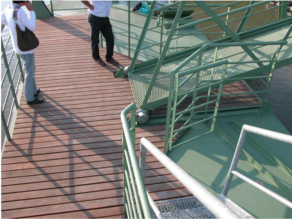
* particolare dei vincoli fra piattaforma di terra e piattaforma in alveo, galleggiante in alveo.
