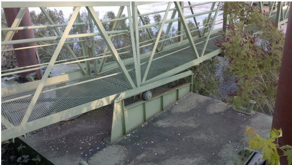
* particolare del collegamento della passerella di terra.
