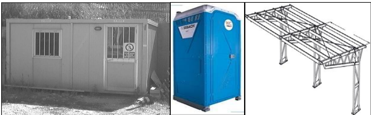
Baraccamenti – Servizi igienici e Tettoia per il rimessaggio automezzi
