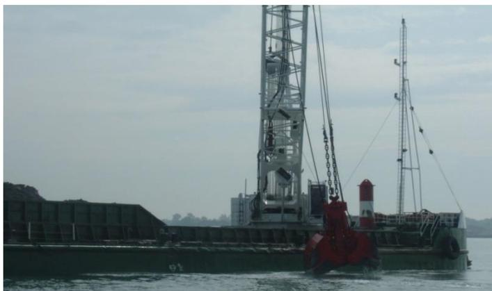
La fase consiste nella regolarizzazione del fondale marino e la preparazione delle quote necessarie per la successiva fase di esecuzione dello scanno di imbasamento della diga
