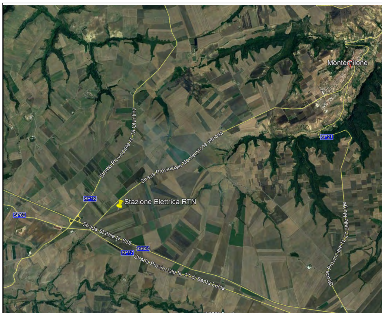
Figura 1 - Veduta aerea della nuova Stazione Elettrica RTN
