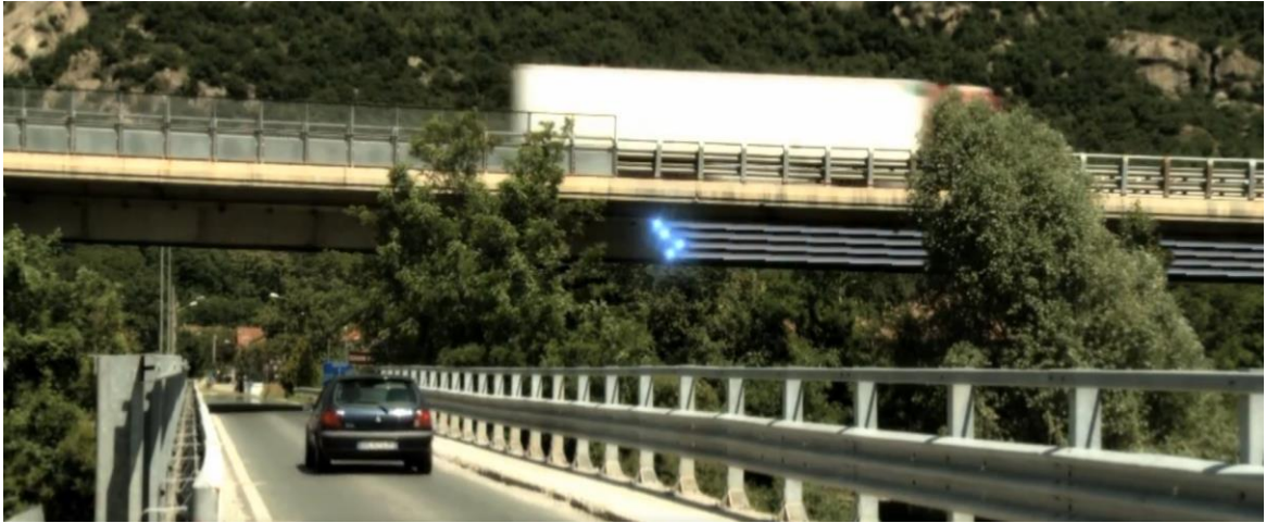
Fonte - video di Terna – interrimento linea da 380 kV Piosasco (Italia) – Grand’Ile (Francia)
