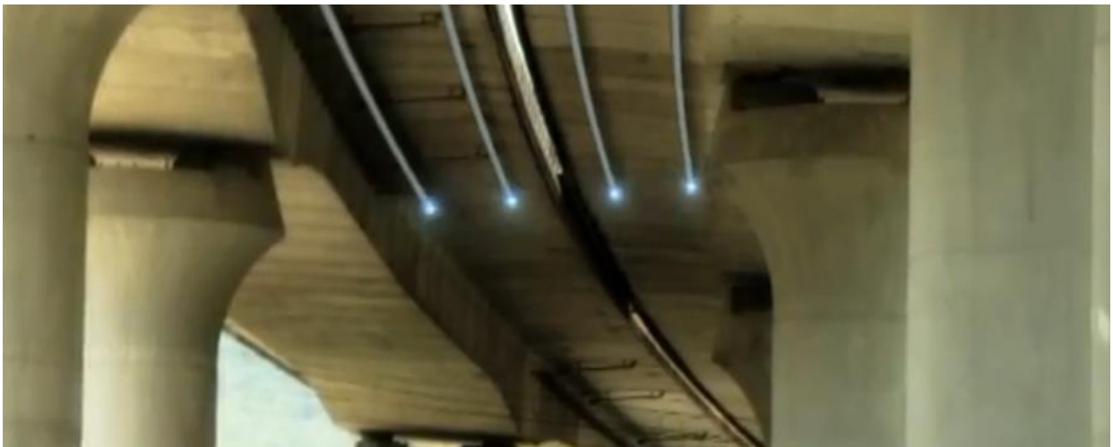
Fonte - video di Terna – interrimento linea da 380 kV Piosasco (Italia) – Grand’Ile (Francia)
