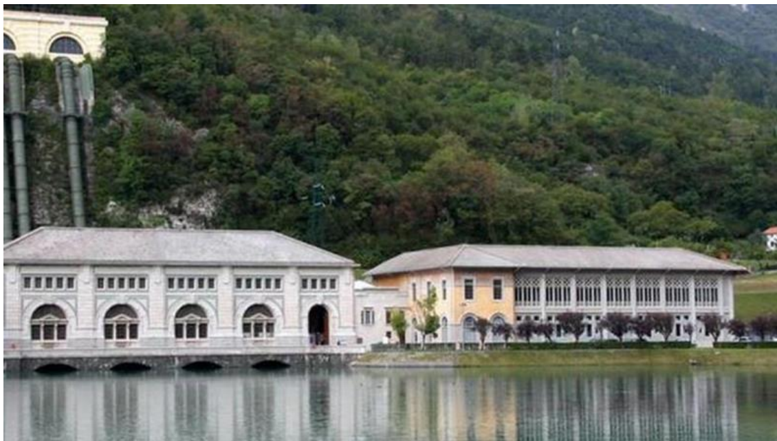
Vittorio Veneto (TV) – centrale elettrica Fadalto 1924
