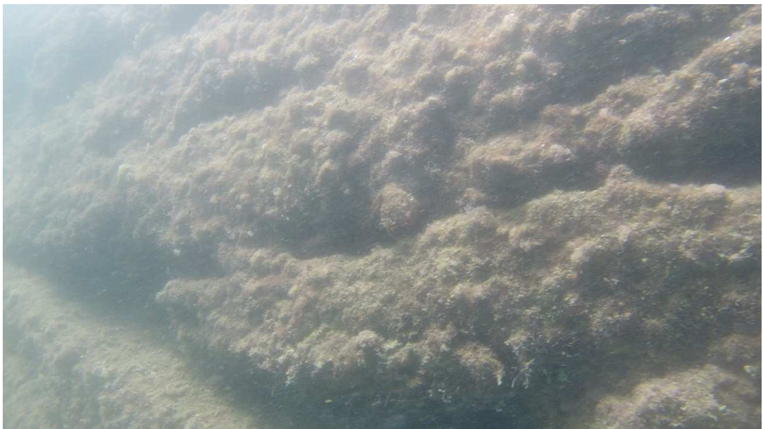
Figura 71 Foto subacquea delle fondamenta di una banchina portuale
