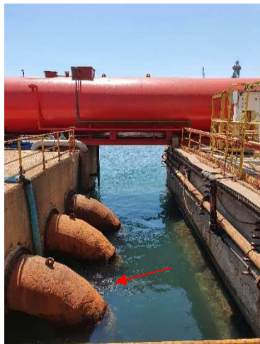
Figura 14 - Impianto di riempimento dello scalo-bacino
