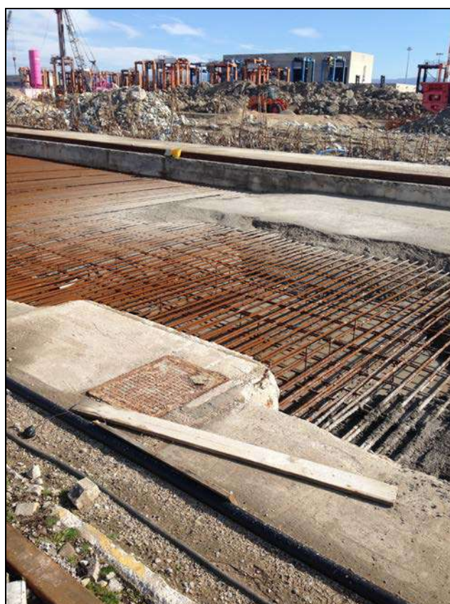
Foto 8 - Lavori in corso nel tratto D: realizzazione solettone in c.a.
