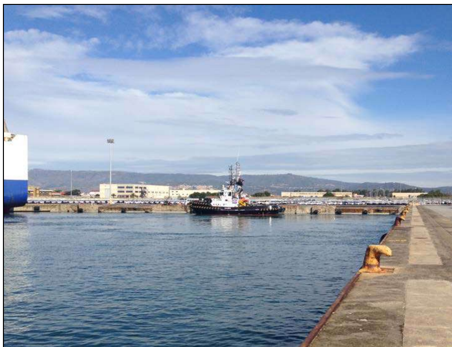
Foto 1 - Vista delle banchine E ed F dalla banchina D
