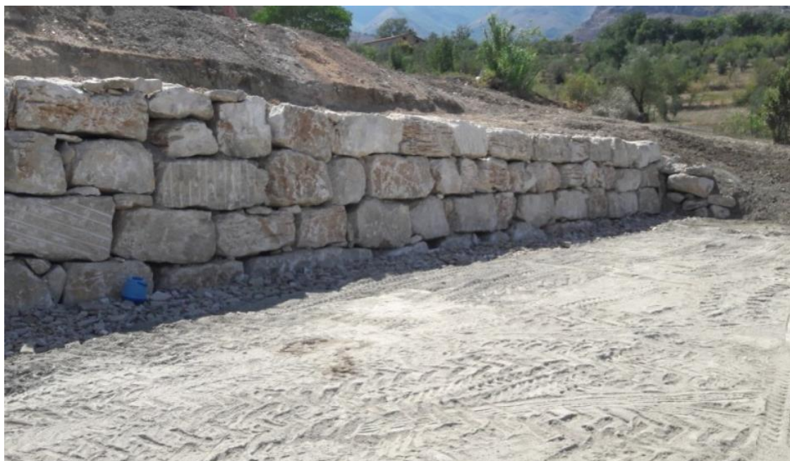
Foto 8.1.1/A – Muro in massi
