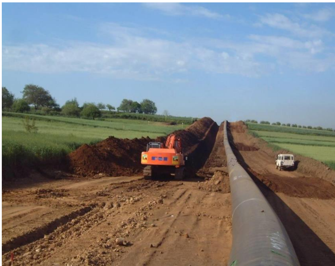
Foto 7.1.6/A - Scavo della trincea
