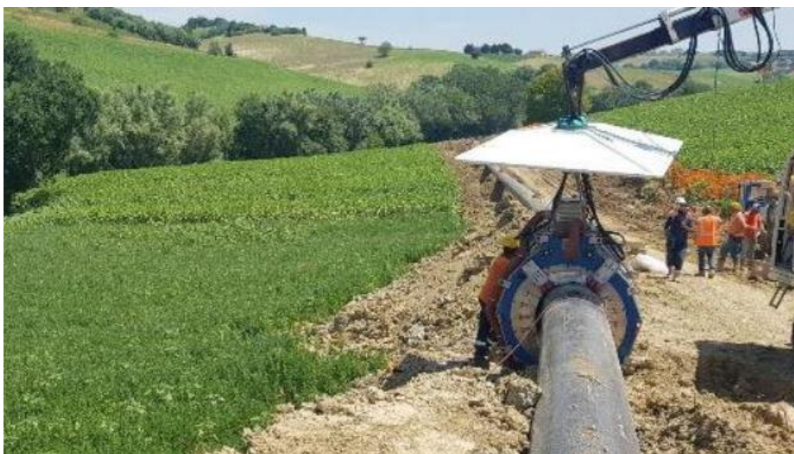
Foto 7.1.4/B - Saldatura automatica
