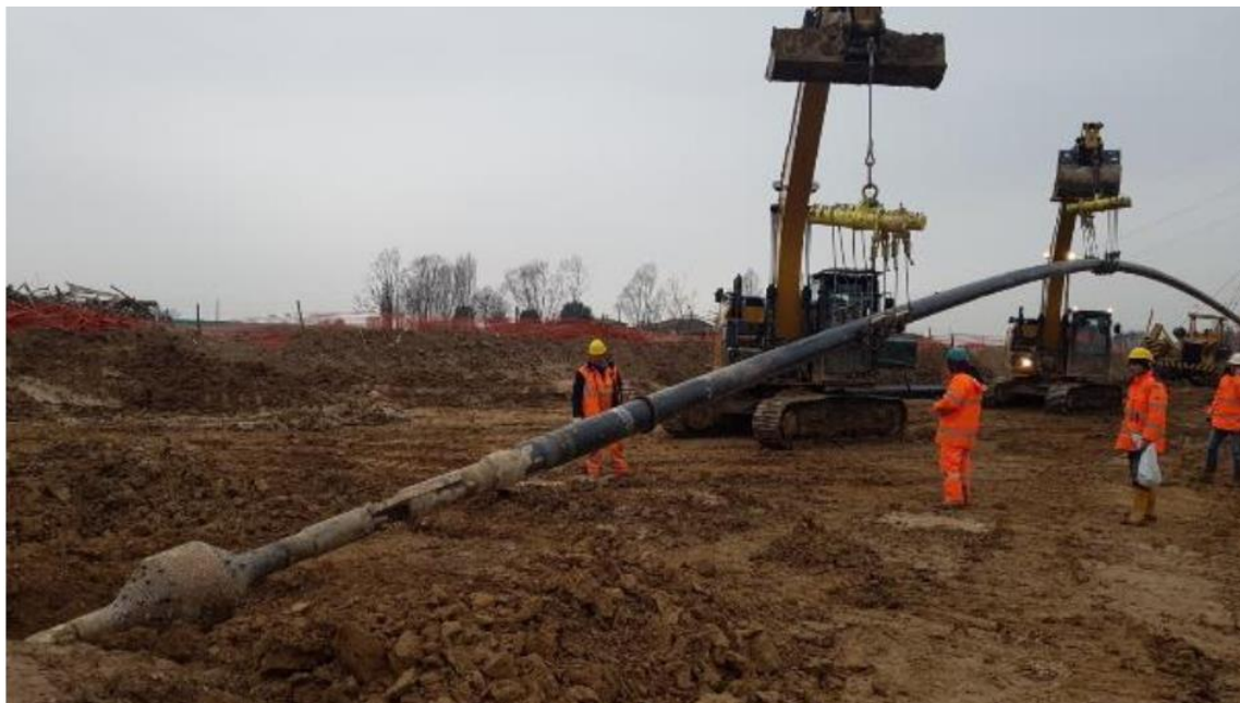
Foto 7.1.11/B - Operazione di varo della TOC
