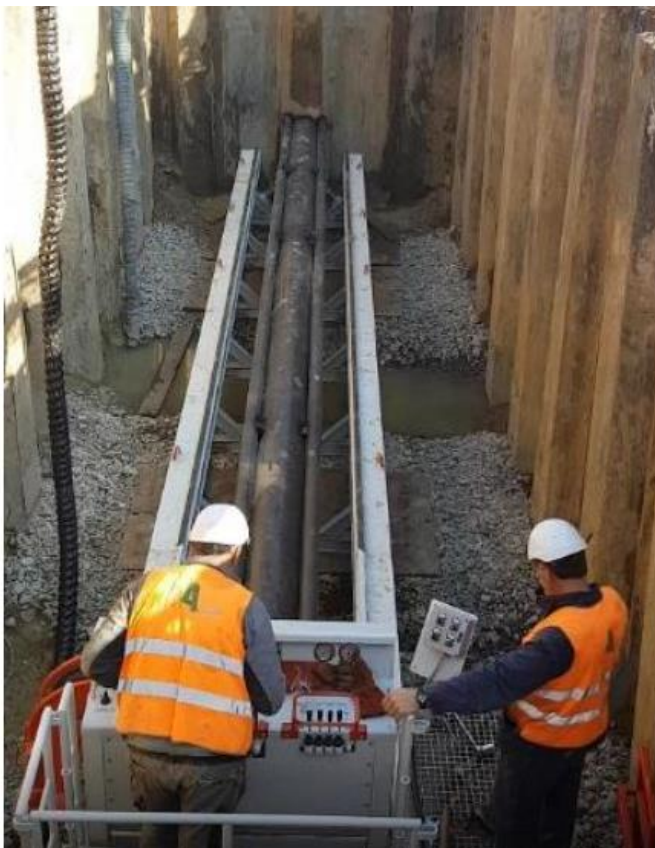
Foto 7.1.10/A - Trivellazione con spingitubo
