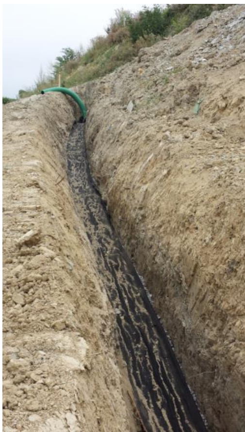
Foto 8.1.1/C – Trincea drenante sotto condotta
