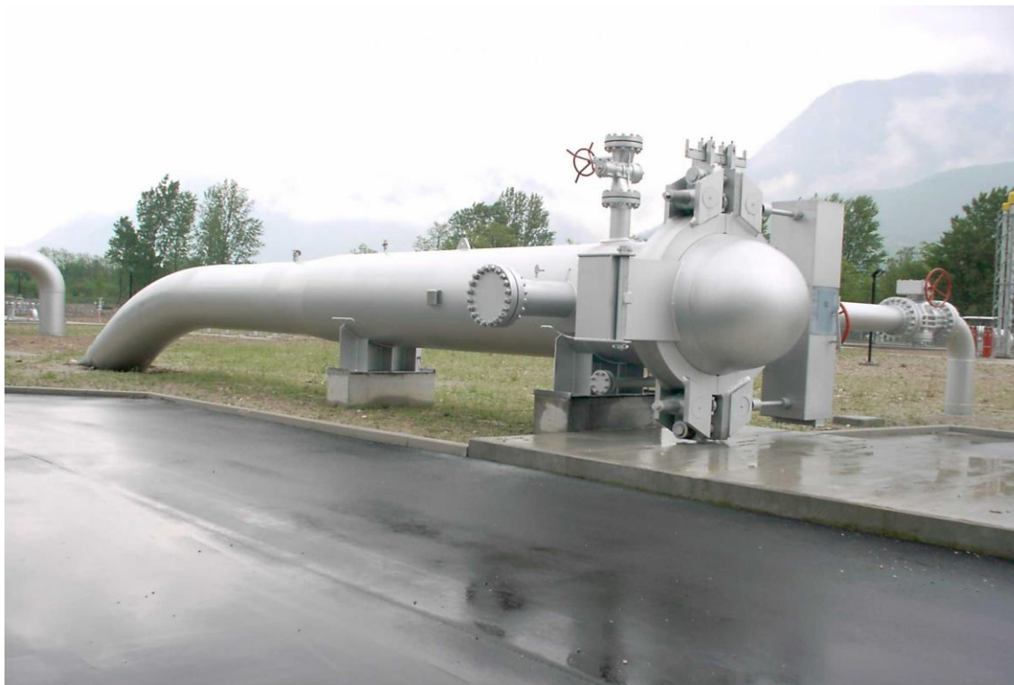
Foto 7.1.12/B - Punto di lancio e ricevimento pig
