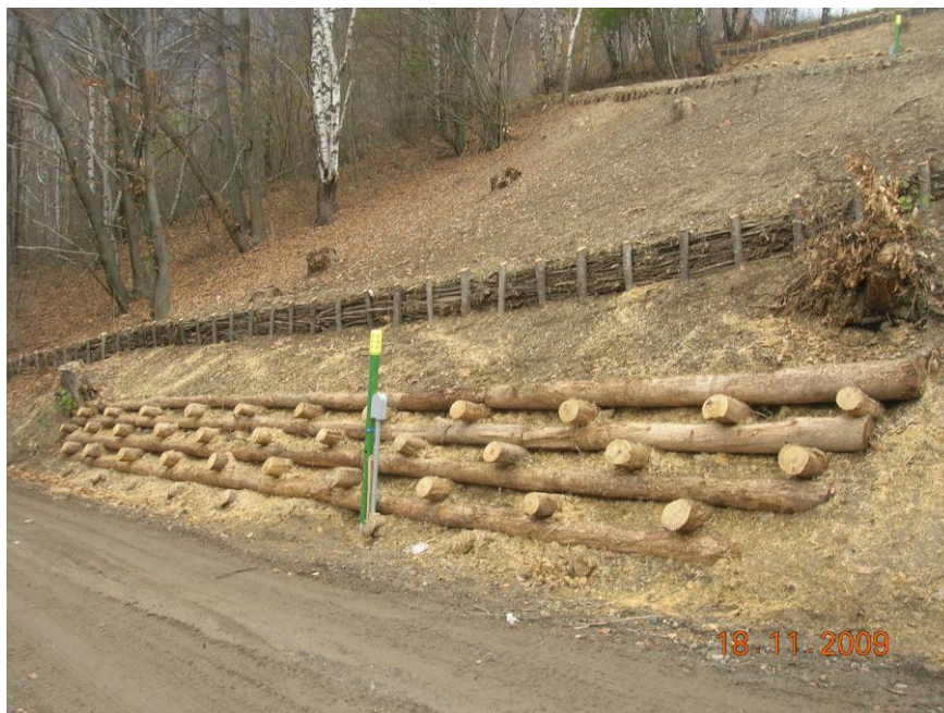
Foto 8.1.1/E – Muro cellulare in legname
