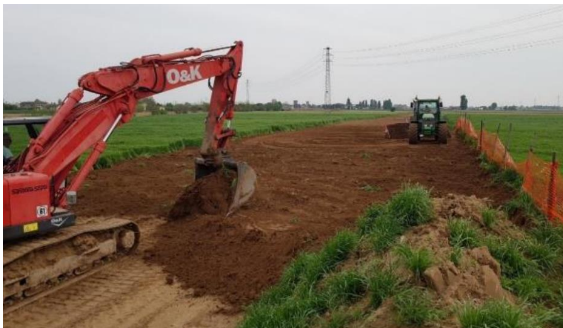
Foto 7.1.9/C - Distribuzione dello strato humico superficiale
