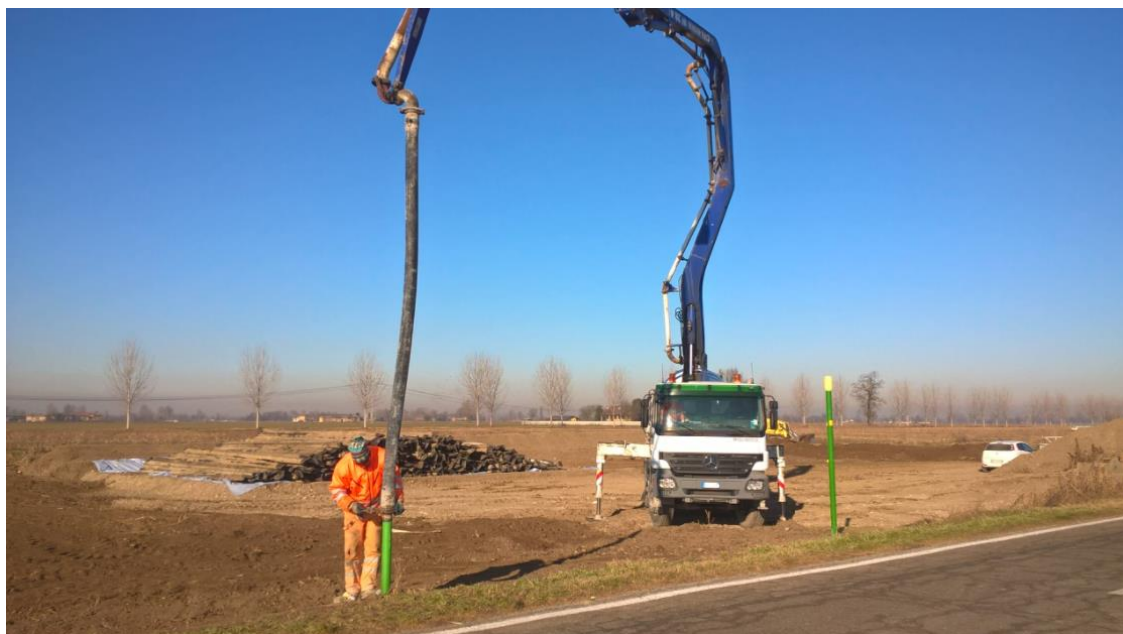
Foto 7.2.7/A – Inertizzazione del tubo di protezione
