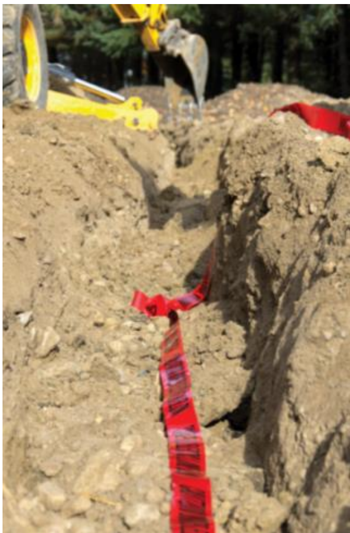
Foto 7.2.3/A – Scavo della trincea e rimozione del nastro di avvertimento
