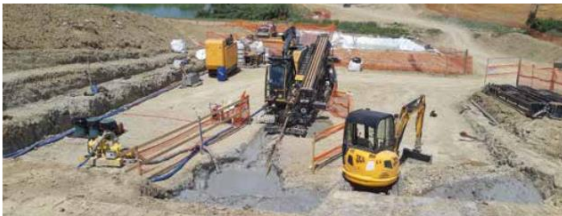
Foto 7.1.11/A – Rig e area di cantiere
