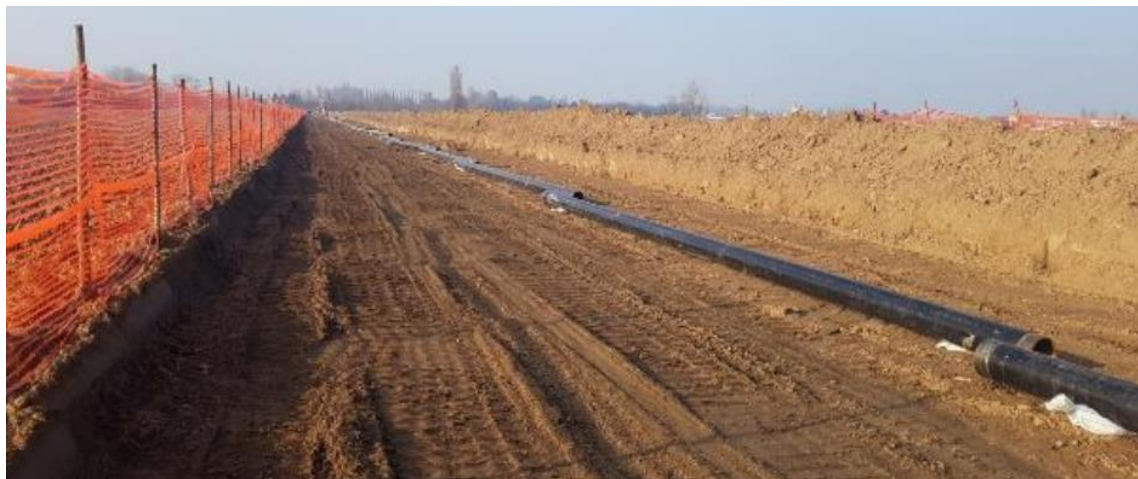
Foto 7.1.3/A – Sfilamento delle tubazioni di linea
