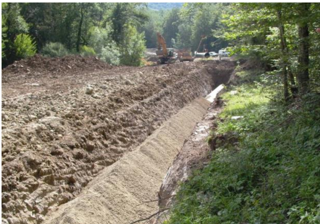
Foto 7.1.9/A – Pre-rinterro della condotta
