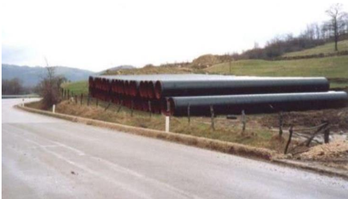
Foto 7.1.1/A - Piazzola di accatastamento tubazioni
