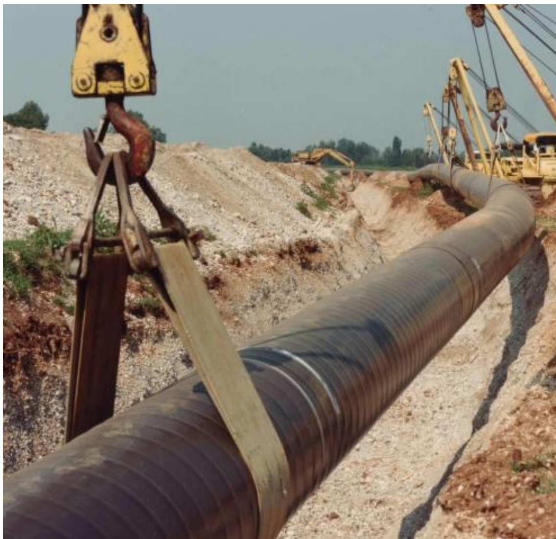
Foto 7.1.8/A – Posa della condotta
