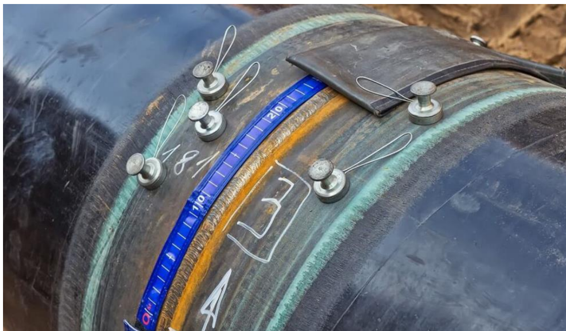
Foto 7.1.5/A - Controlli non distruttivi sulle saldature
