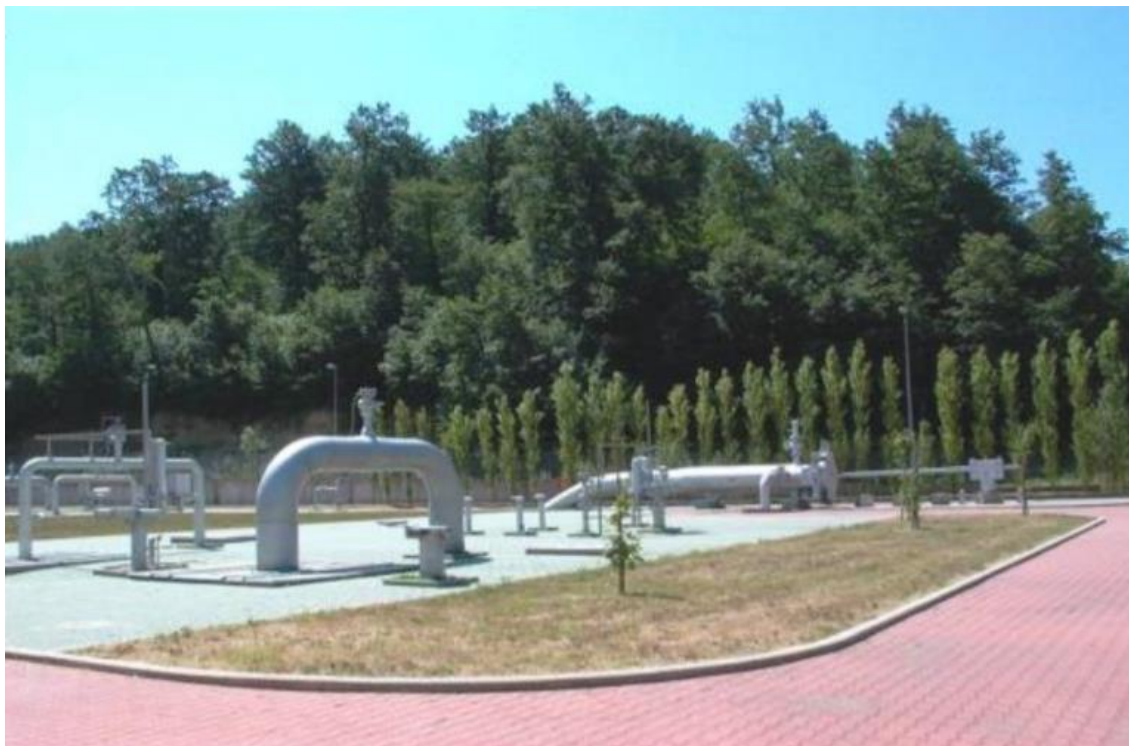
Foto 7.1.12/C – Allestimento area trappole
