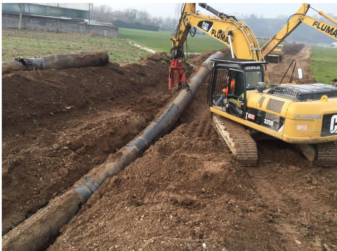
Foto 7.2.5/A - Sollevamento tubazione sezionata da rimuovere
