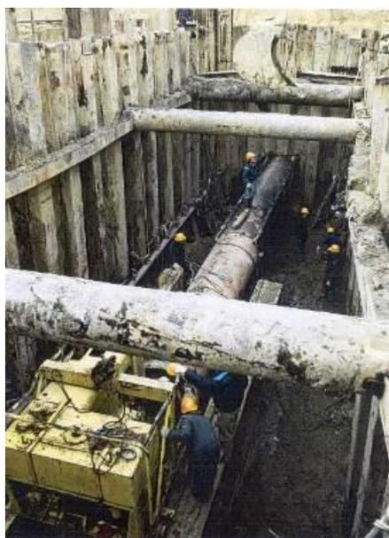
**Foto 2.2-7: Trivellazione con spingitubo**
