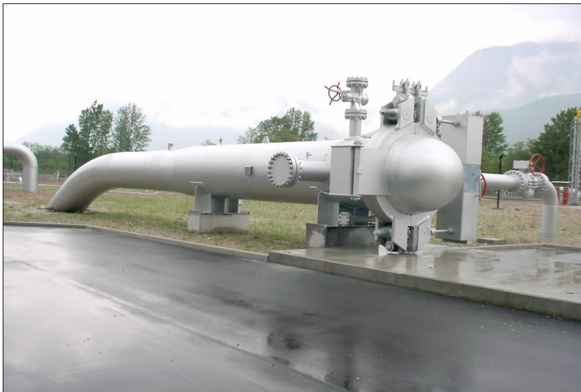
Foto. 2.2/A: Punto di lancio e ricevimento pig
