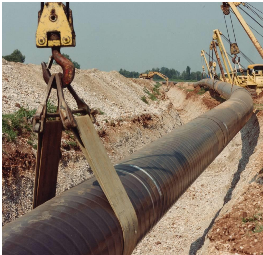
Foto 2.3/H: Posa della condotta (esempio di condotta con diametro superiore alla linea in progetto)
