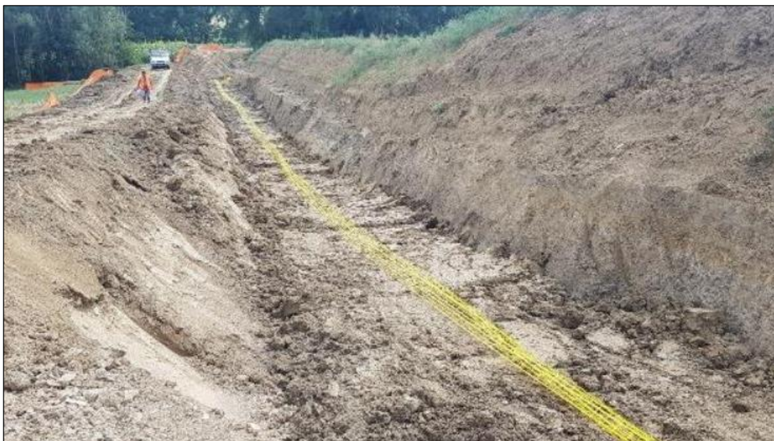
Foto 2.3/J: Rinterro della condotta
