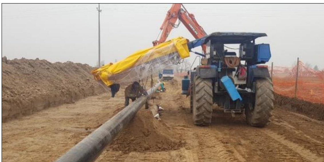
Foto 2.3/D Esempio di saldatura manuale
