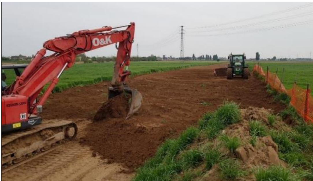
Foto 2.3/K: Distribuzione dello strato humico superficiale
