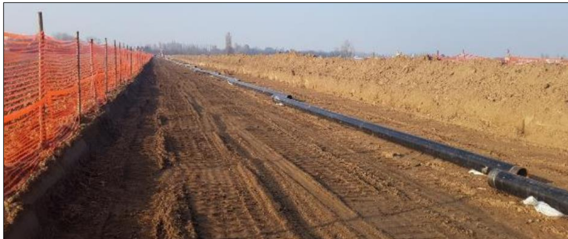
Foto 2.3/C Sfilamento tubazioni
