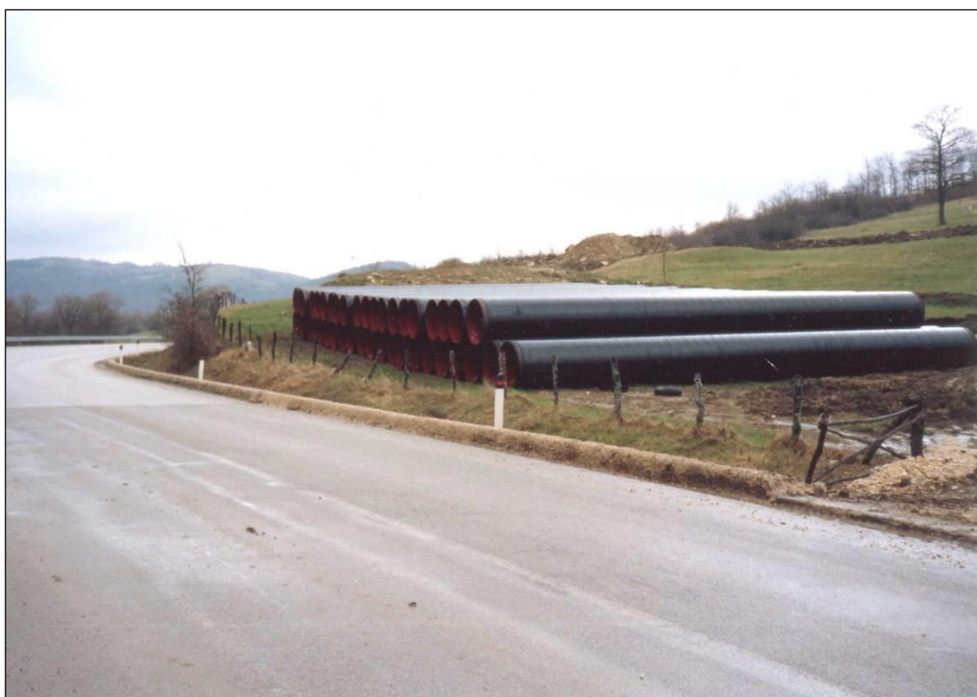
Foto 2.3/A Esempio di piazzola di accatastamento tubazioni
