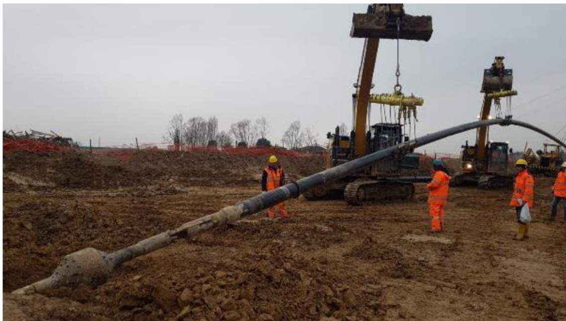
Foto 2.3/N Esempio di operazione di varo della TOC
