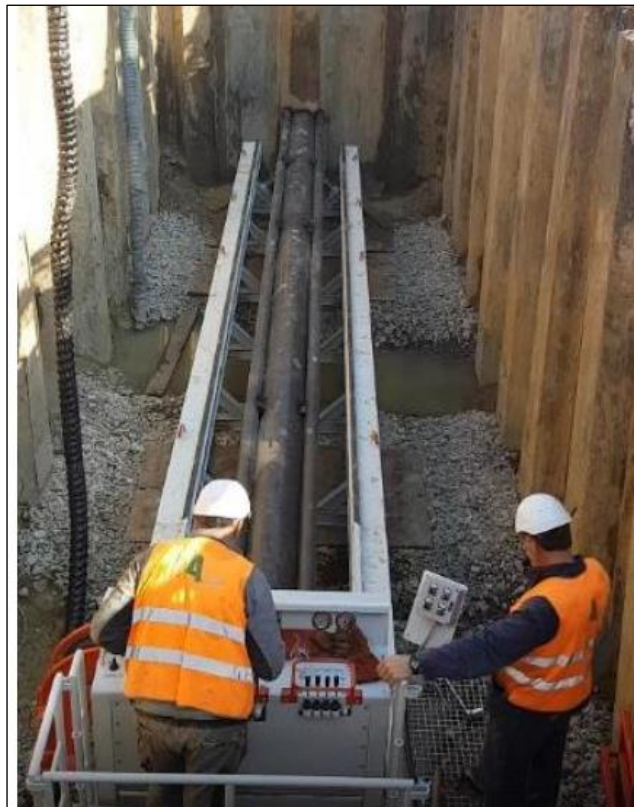
Foto 2.3/L: Trivellazione con spingitubo
