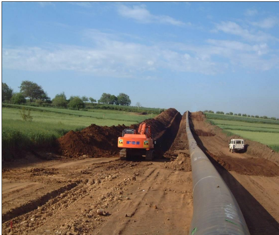
Foto 2.3/F Scavo della trincea
