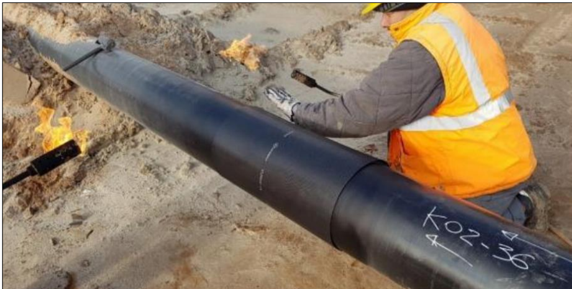
Foto 2.3/G Applicazione manuale di una fascia termorestringente su giunto di saldatura
