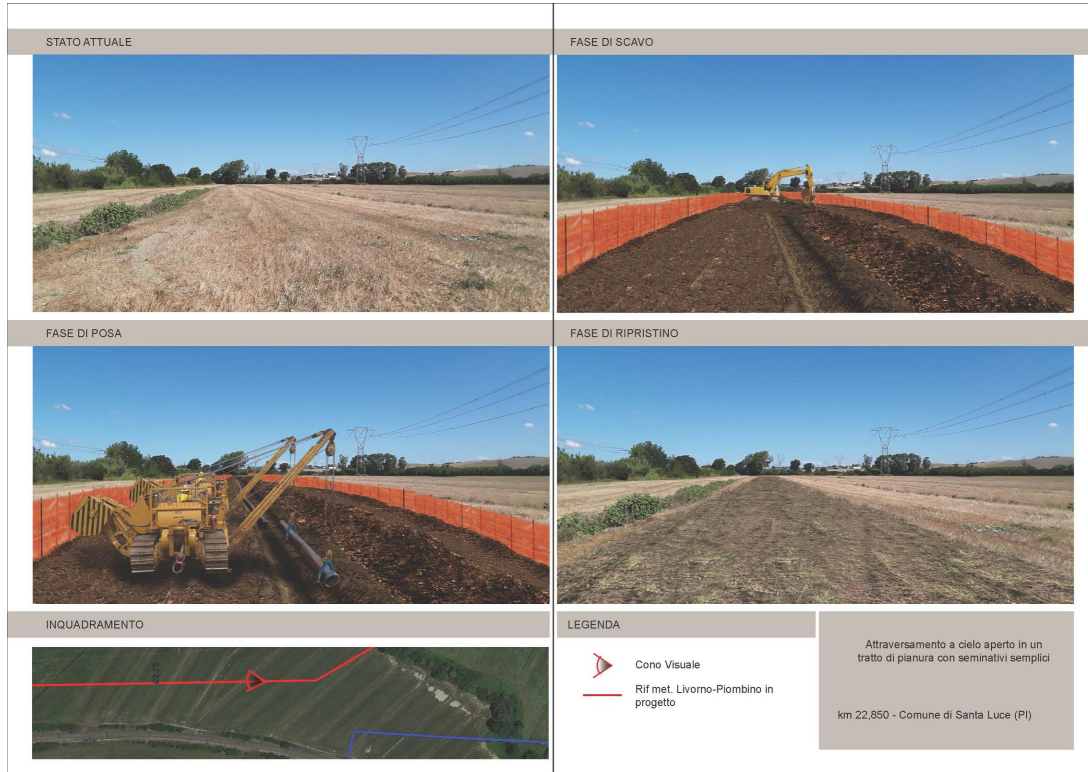
Fig. 6.1/A: Fotosimulazione dell'attraversamento a cielo aperto di un tratto di pianura con seminativi semplici
