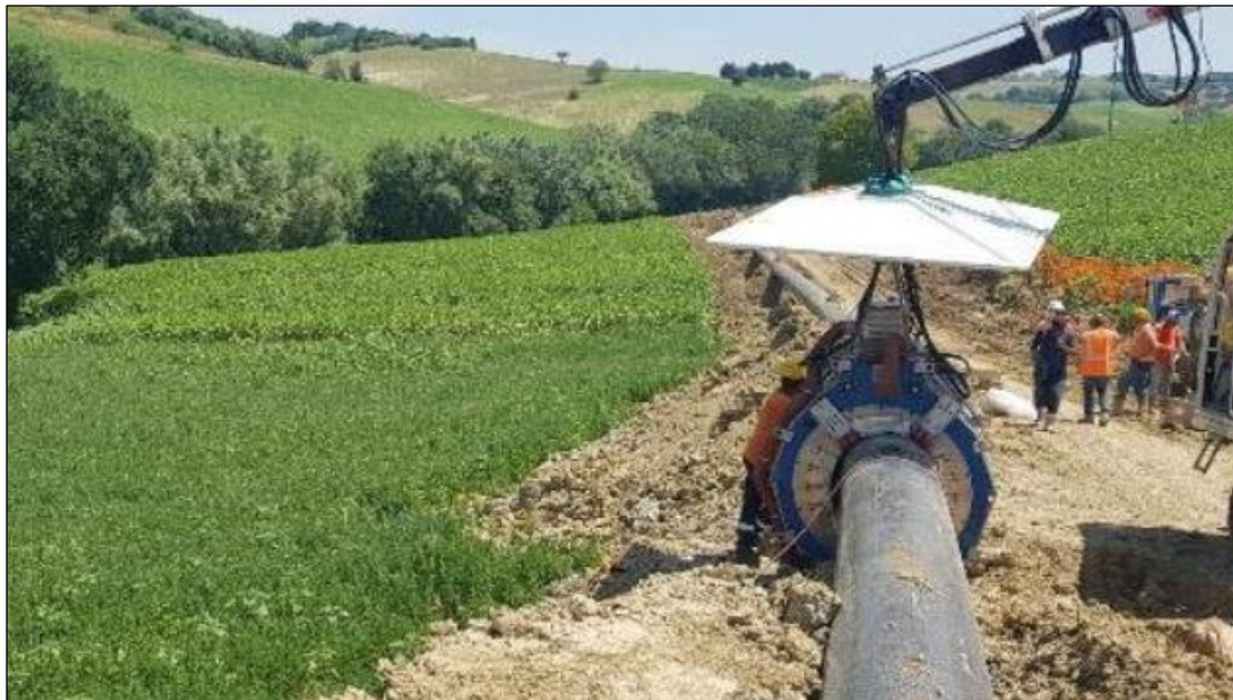
Foto 2.3/E Esempio di saldatura automatica
