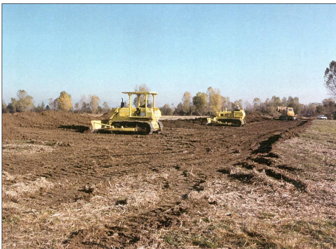
Foto 2.3/B Apertura dell'area di passaggio
