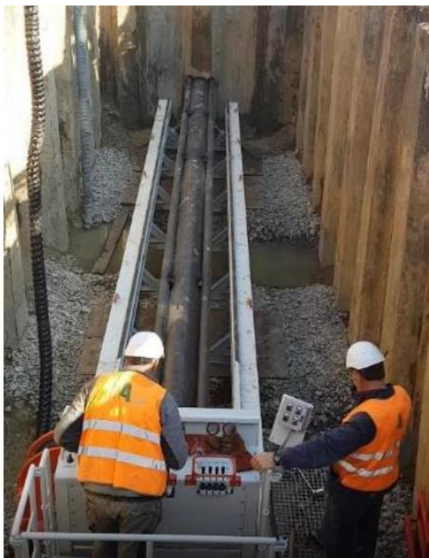
Foto 3.3.4.10/A - Trivellazione con spingitubo
