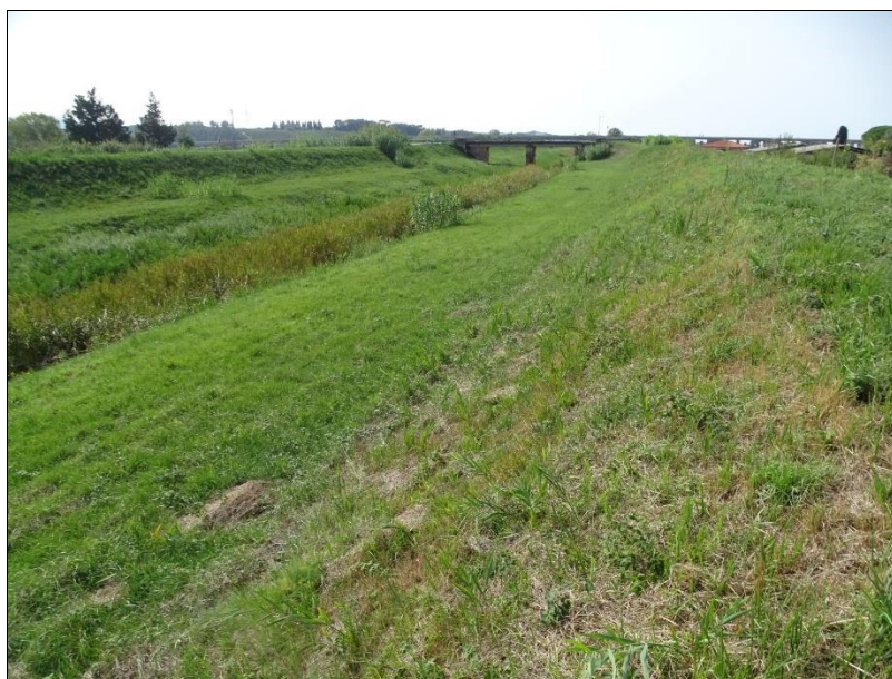
Fig. 5.3.1/K - Ambito prativo posto su grande argine con frequenti sfalci (argine del Torrente Tora presso Collesalveti)
