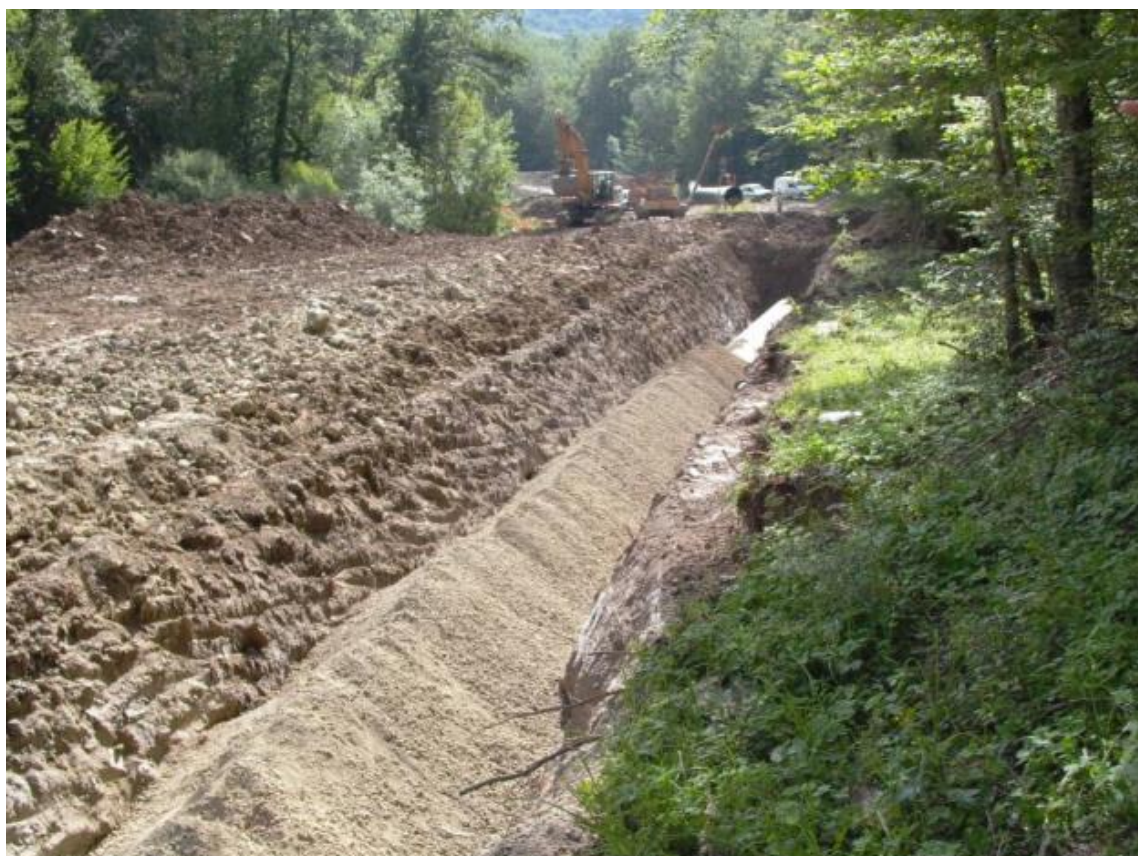
Foto 3.3.4.9/A - Rinterro della condotta
