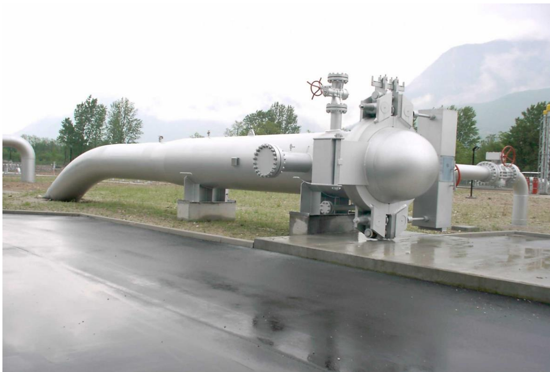
Foto 3.3.2.7/A - Punto di lancio e ricevimento pig
