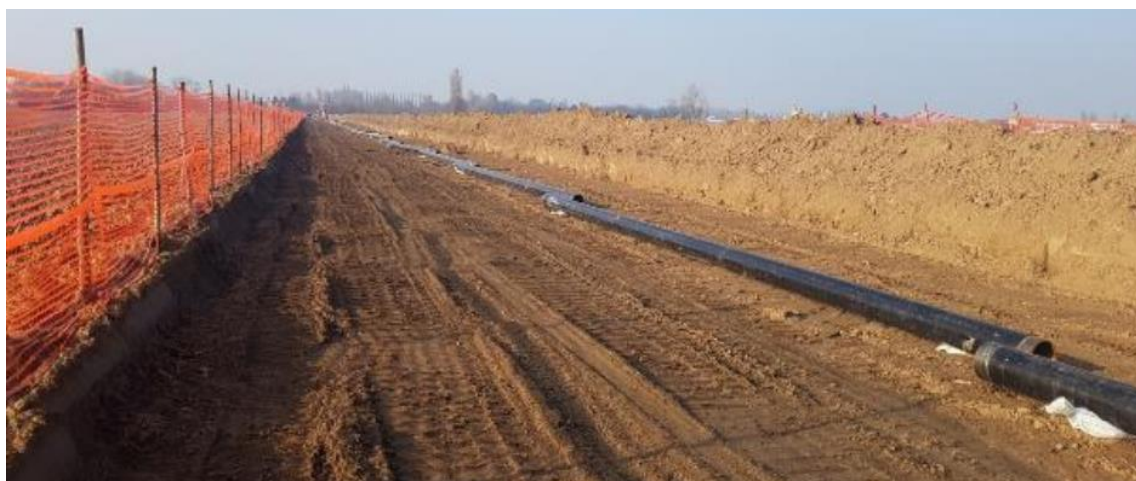
Foto 3.3.4.3/A – Sfilamento delle tubazioni di linea
