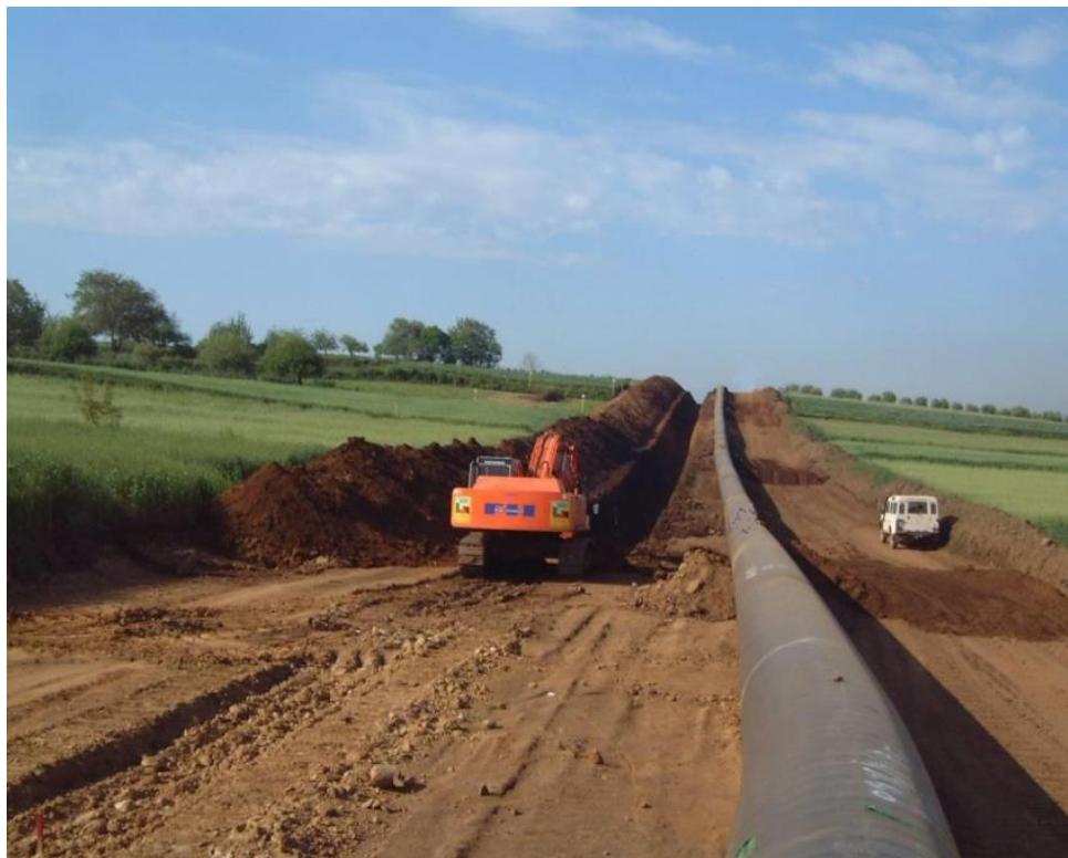
Foto 3.3.4.6/A - Scavo della trincea
