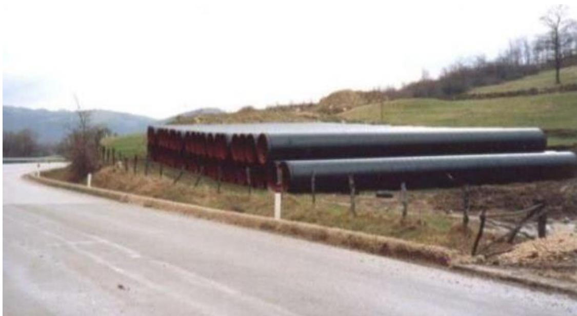
Foto 3.3.4.1/A - Piazzola di accatastamento tubazioni
