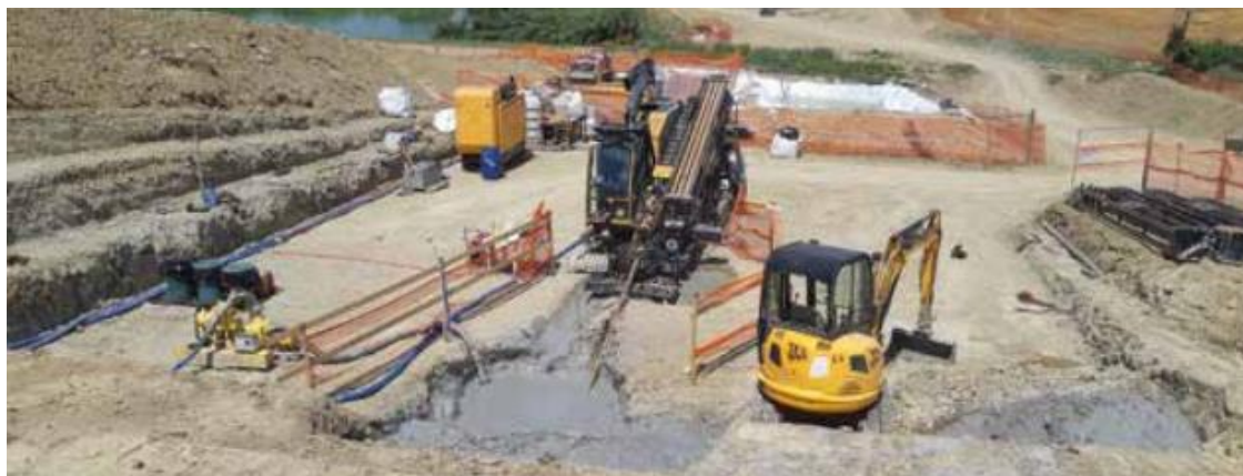
Foto 3.3.4.11/A – Rig e area di cantiere
