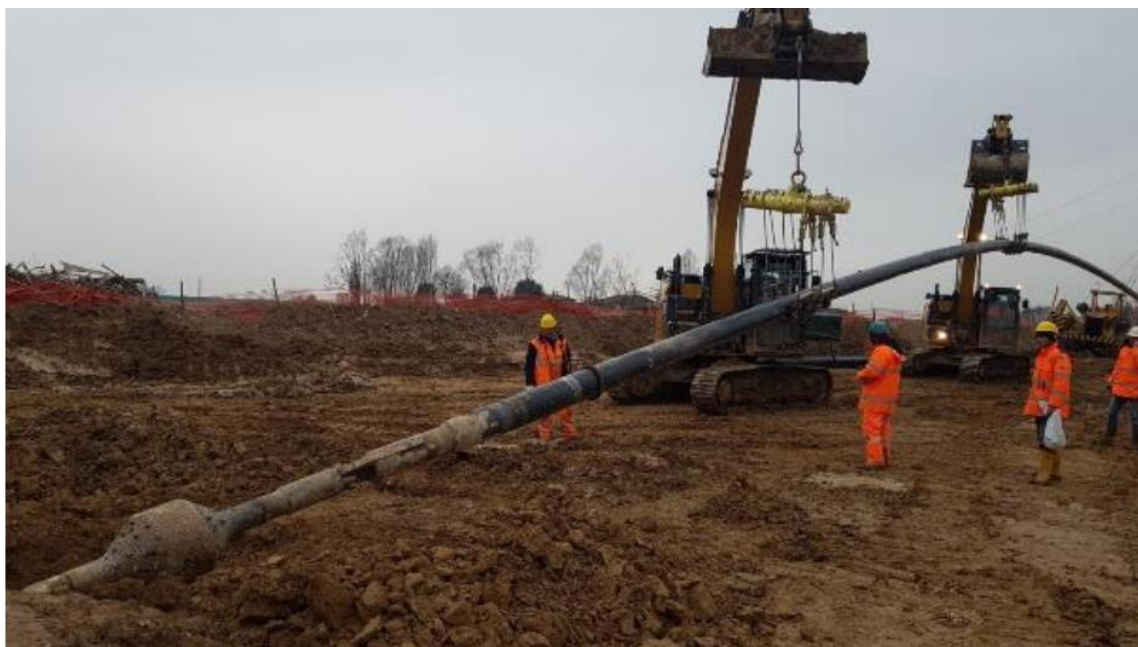
Foto 3.3.4.11/B - Operazione di varo della TOC
