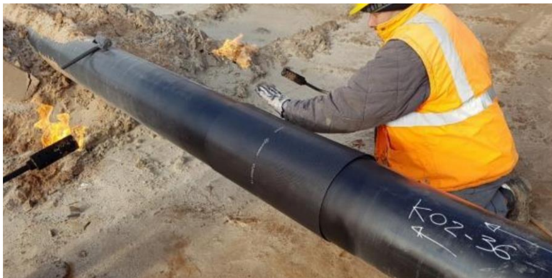
Foto 3.3.4.7/A - Applicazione manuale di una fascia termorestringente su giunto di saldatura
