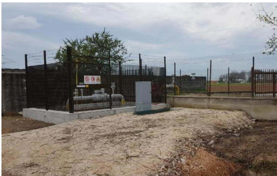
Foto 3.3.4.12/A - Esempio di impianto al termine dei lavori
