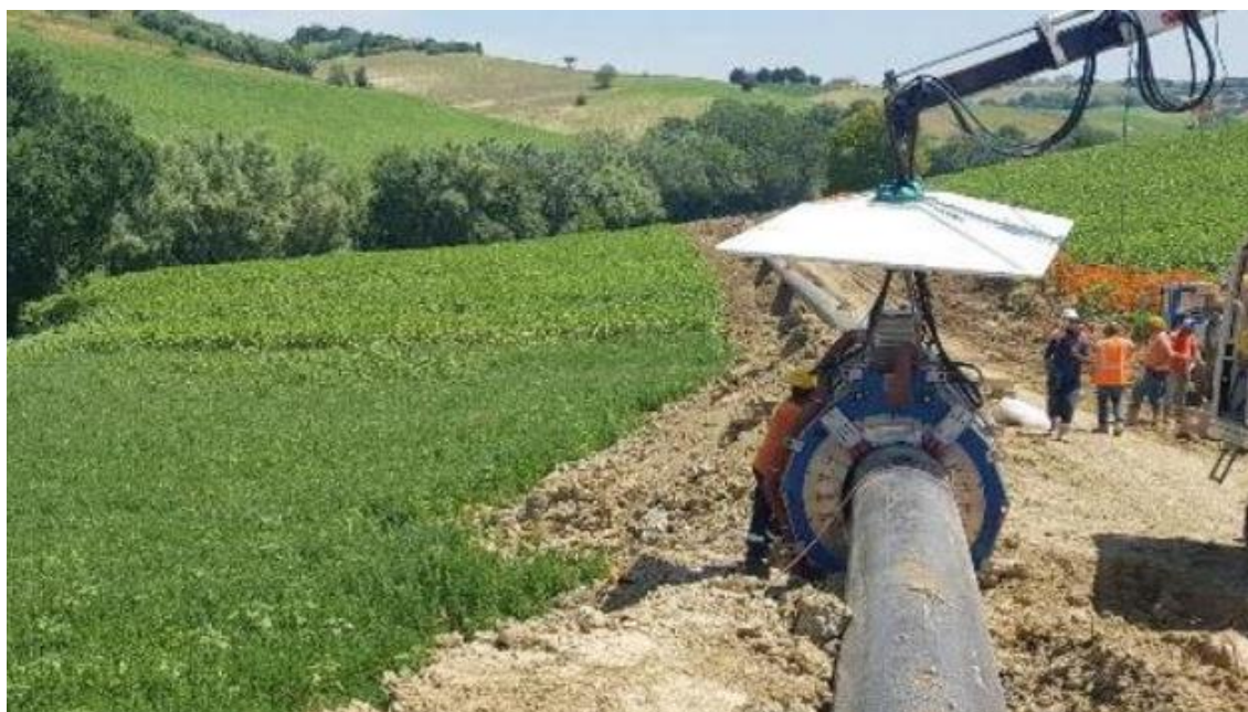
Foto 3.3.4.4/B - Saldatura automatica
