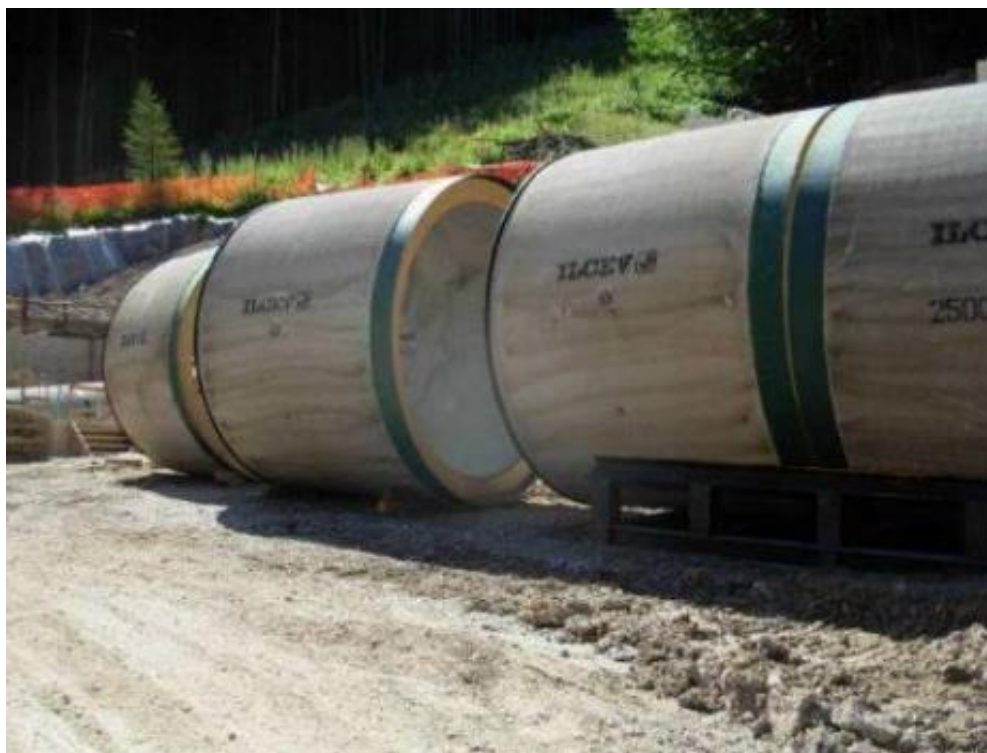
Foto 3.3.4.11/E - Stoccaggio tubi in c.a
