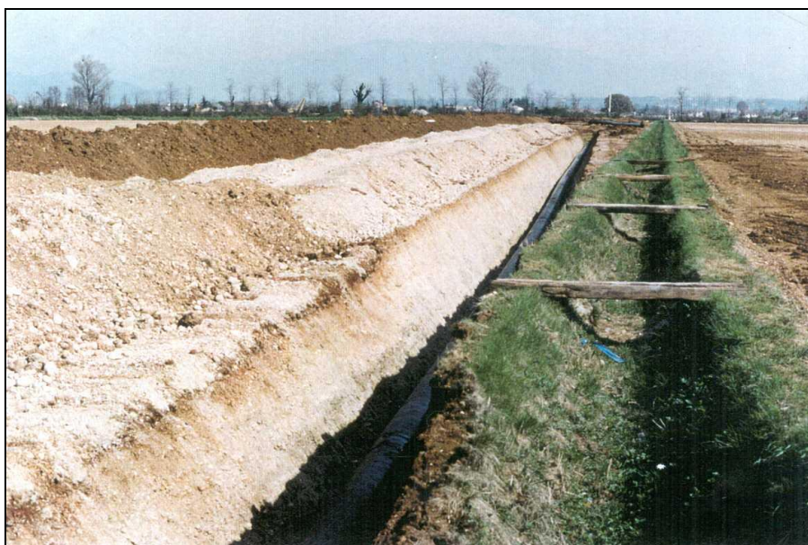
Foto 3.3/I: Tratto di condotta posata, si nota l'accantonamento dello strato humico separato dal materiale di scavo della trincea
