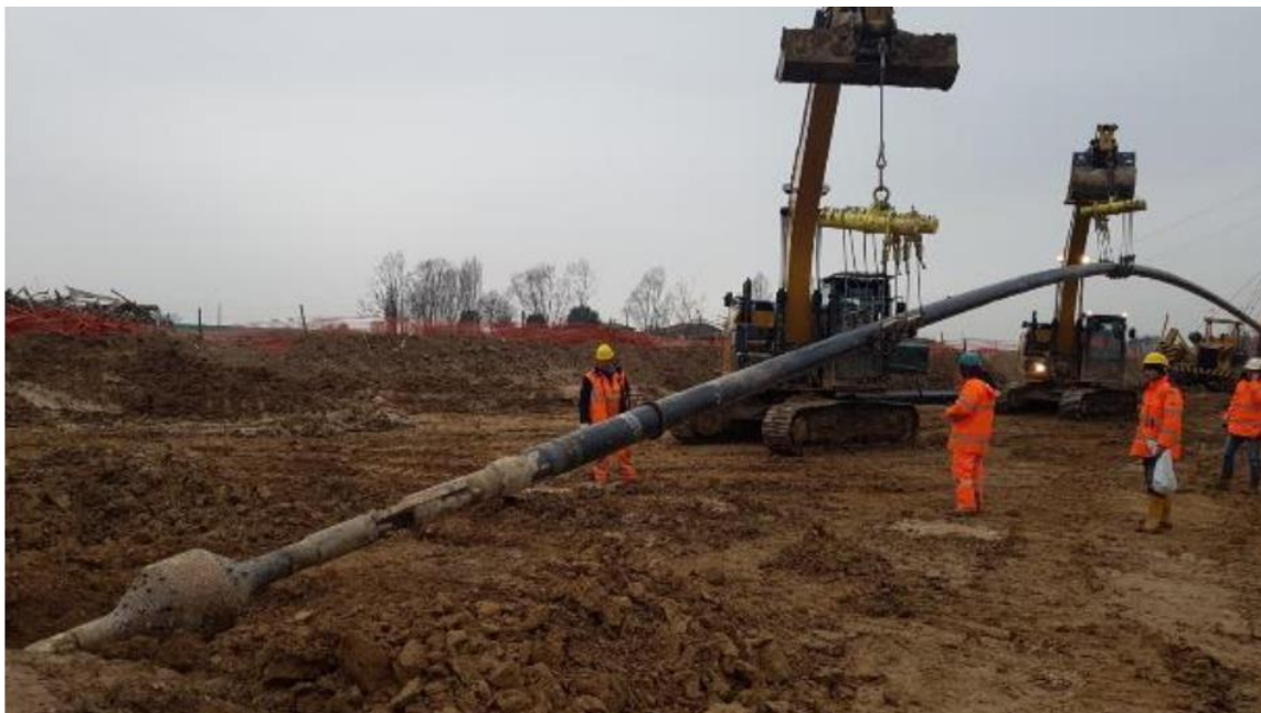
Fig. 4.2/C - Esempio di operazione di varo della TOC
