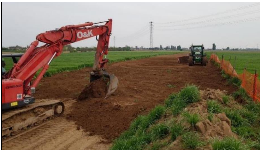
Foto 3.3/K: Distribuzione dello strato humico superficiale
