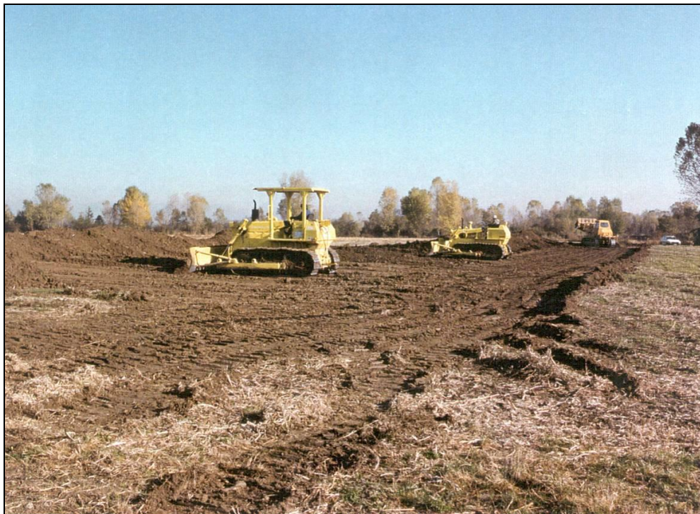
Foto 3.3/B Apertura dell'area di passaggio
