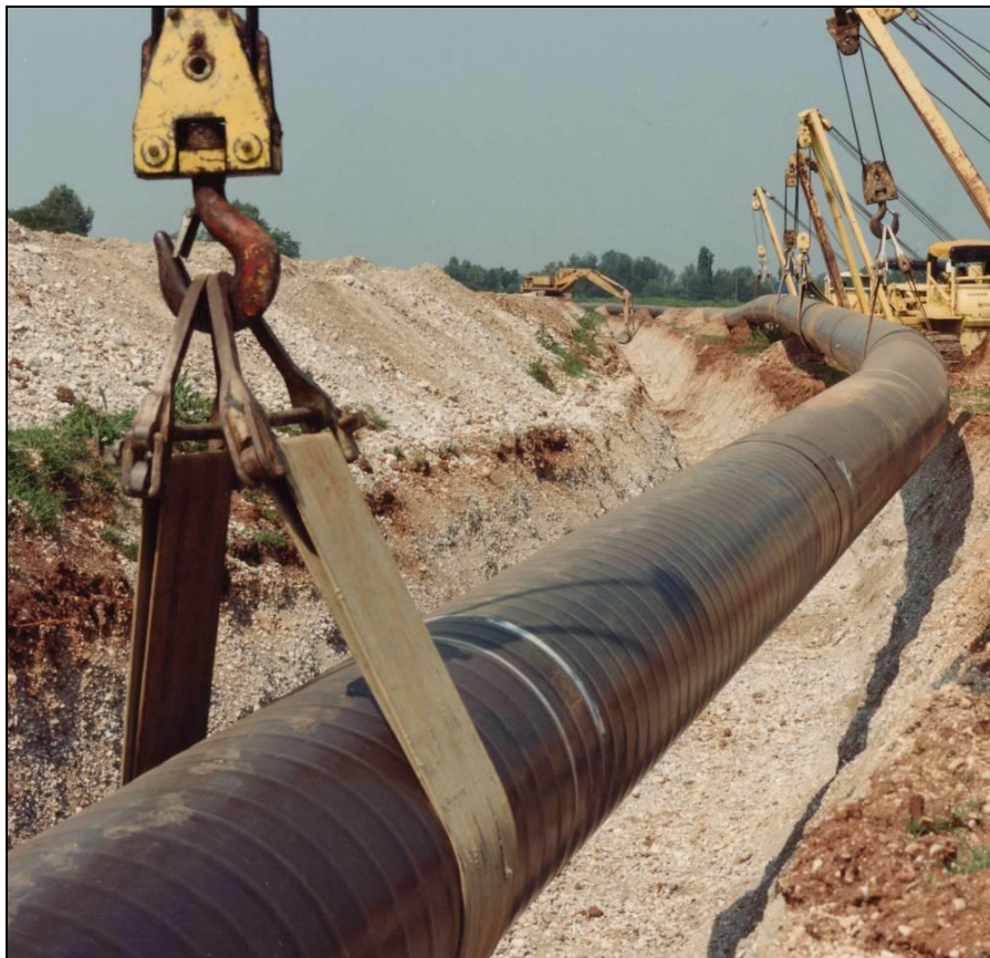
Foto 3.3/H: Posa della condotta (esempio di condotta con diametro superiore alla linea in progetto)
