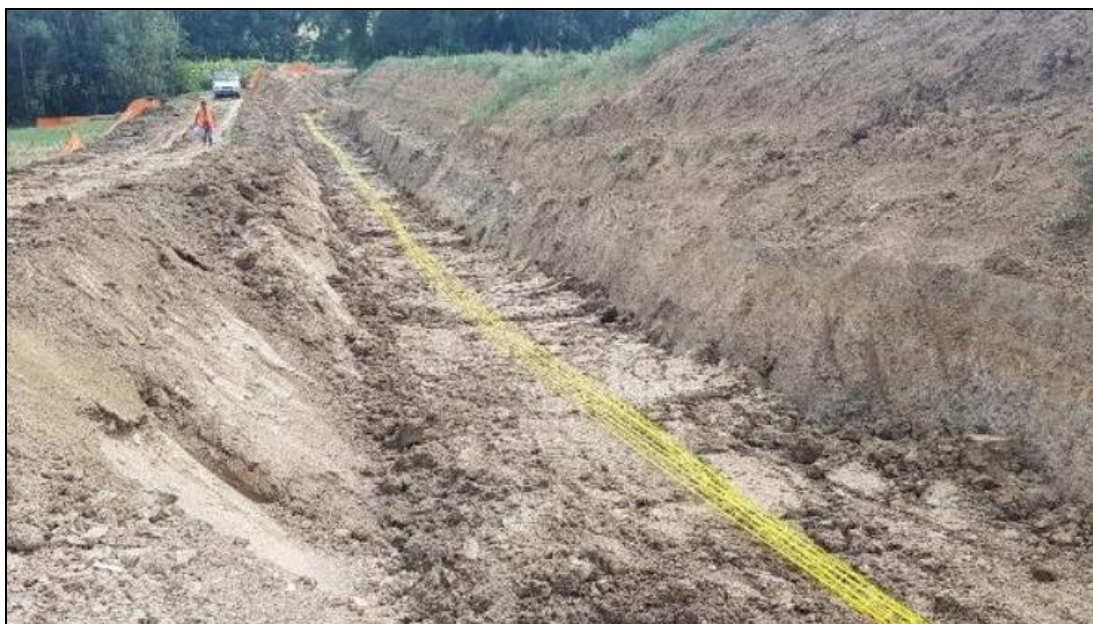
Foto 3.3/J: Rinterro della condotta
