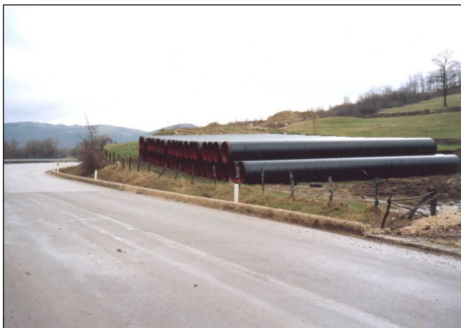
Foto 3.3/A Esempio di piazzola di accatastamento tubazioni
