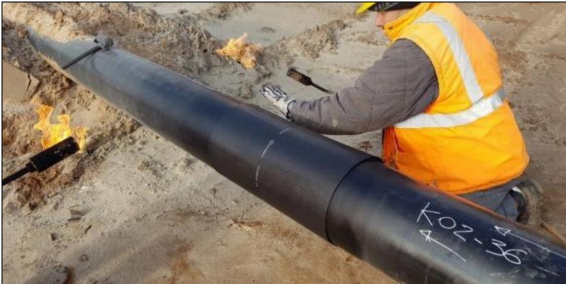
Foto 3.3/G Applicazione manuale di una fascia termorestringente su giunto di saldatura
