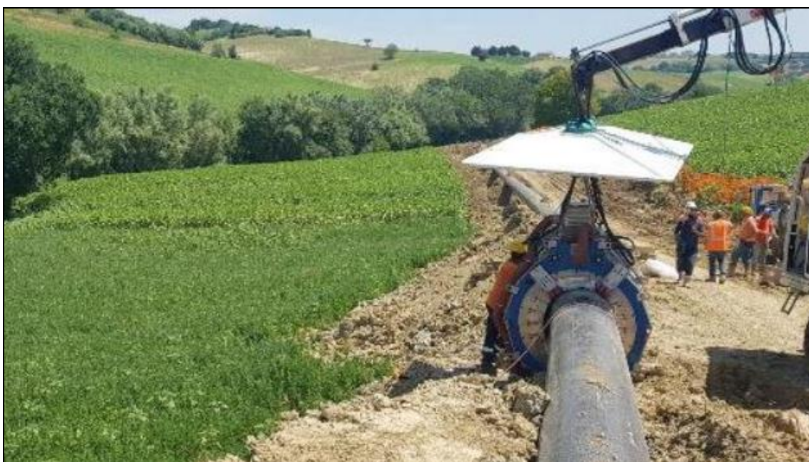
Foto 3.3/E Esempio di saldatura automatica
