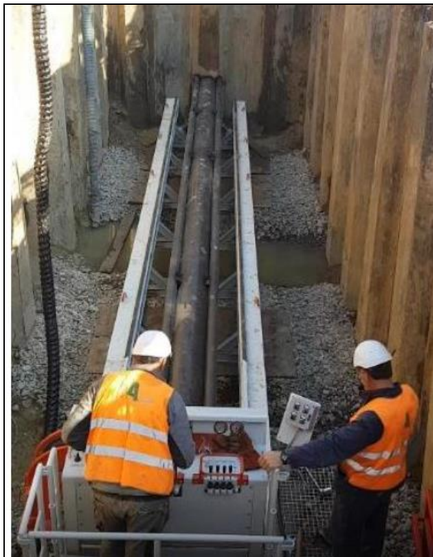
Foto 3.3/L: Trivellazione con spingitubo
