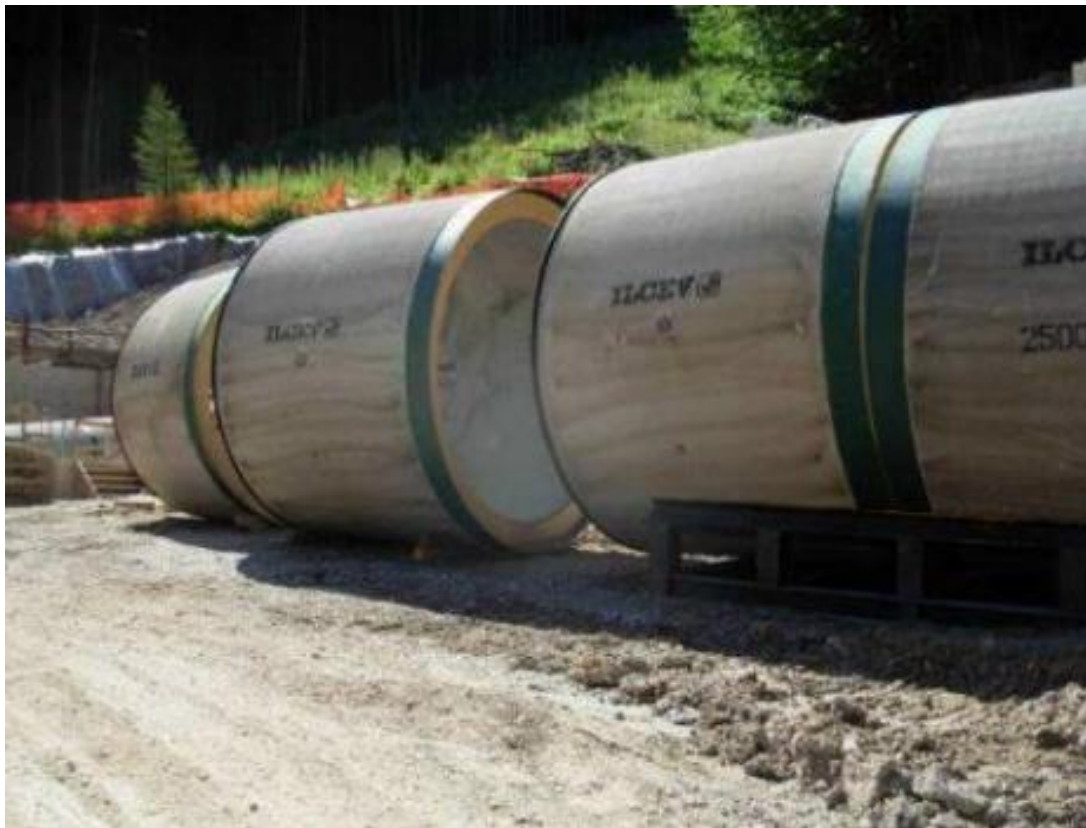
Fig. 4.2/H - Stoccaggio tubi in c.a.
