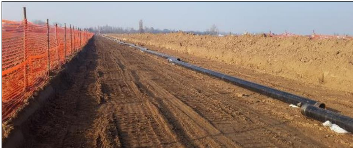
Foto 3.3/C Sfilamento tubazioni
