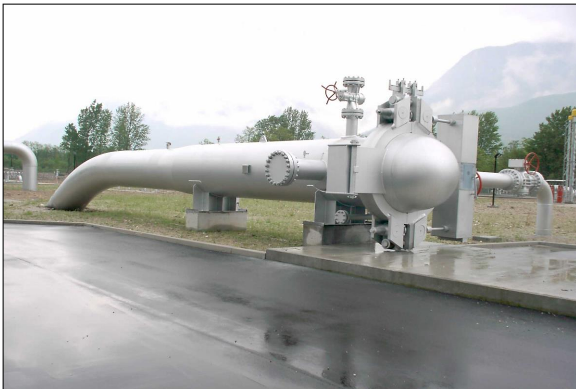
Fig. 3.2/A: Punto di lancio e ricevimento pig
