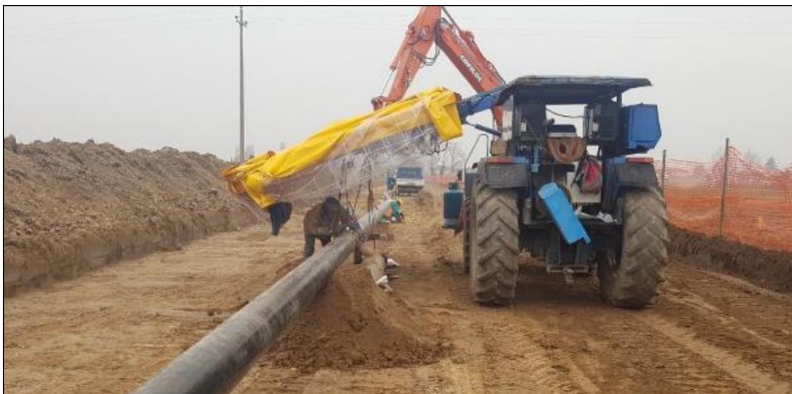
Foto 3.3/D Esempio di saldatura manuale
