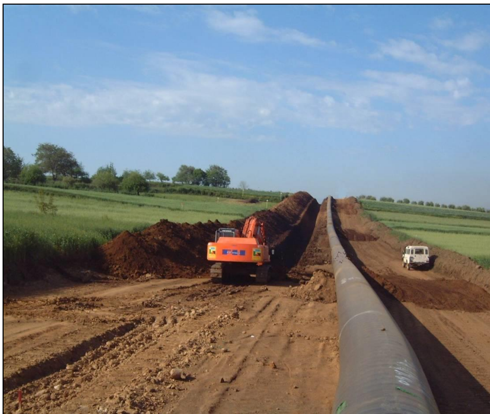
Foto 3.3/F Scavo della trincea
