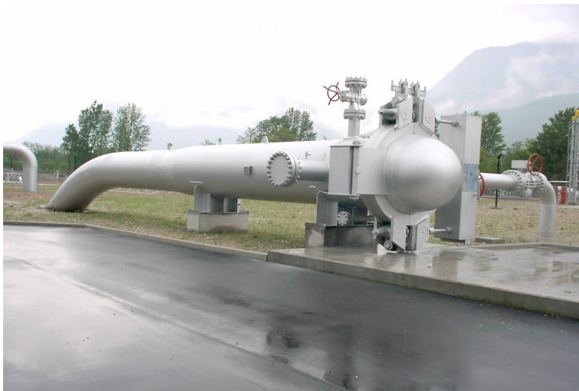
Fig 2.1 - Punto di lancio e ricevimento pig
