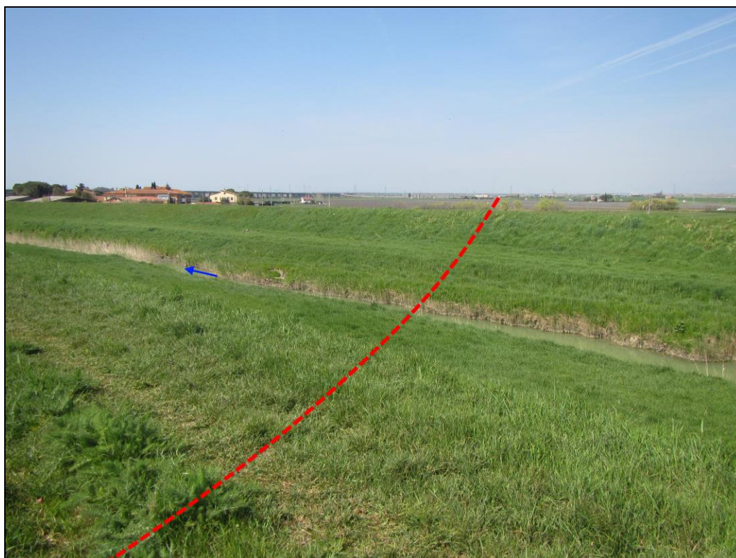
Fig.3.2/B: Foto ambito d'attraversamento
