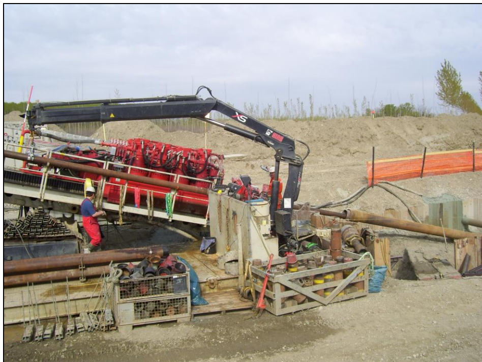
Attravers. F. Po con met. 30" – "Rig", durante la realizzazione del foro pilota
