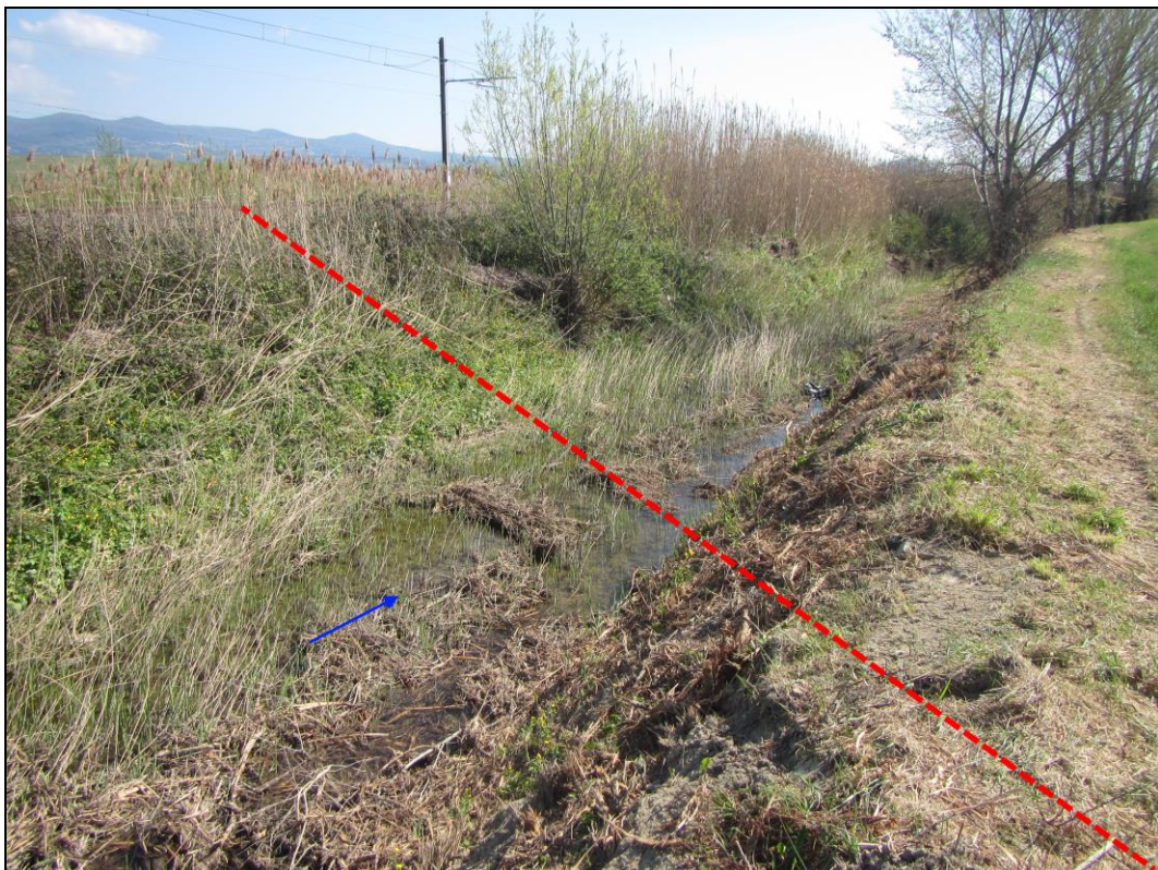
Fig.3.2/B: Foto ambito 2° attraversamento torrente Savalano
