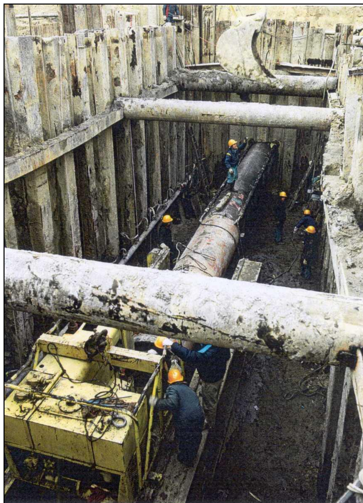
Trivellazione con spingitubo
