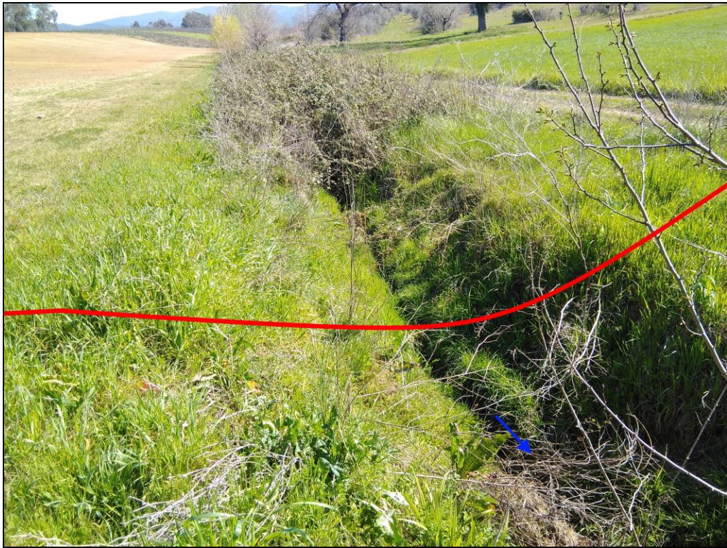
Fig.3.2/C: Foto ambito d'attraversamento fosso Meluccio
