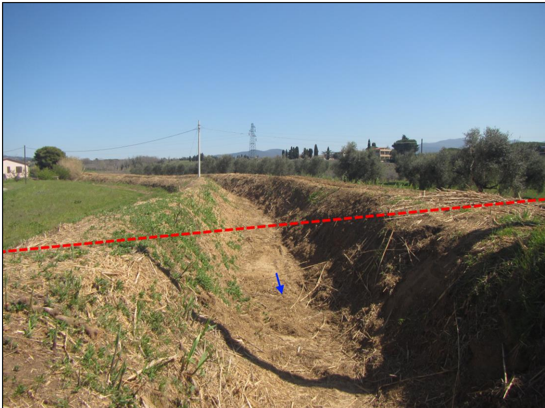
Fig.3.2/B: Foto ambito d'attraversamento
