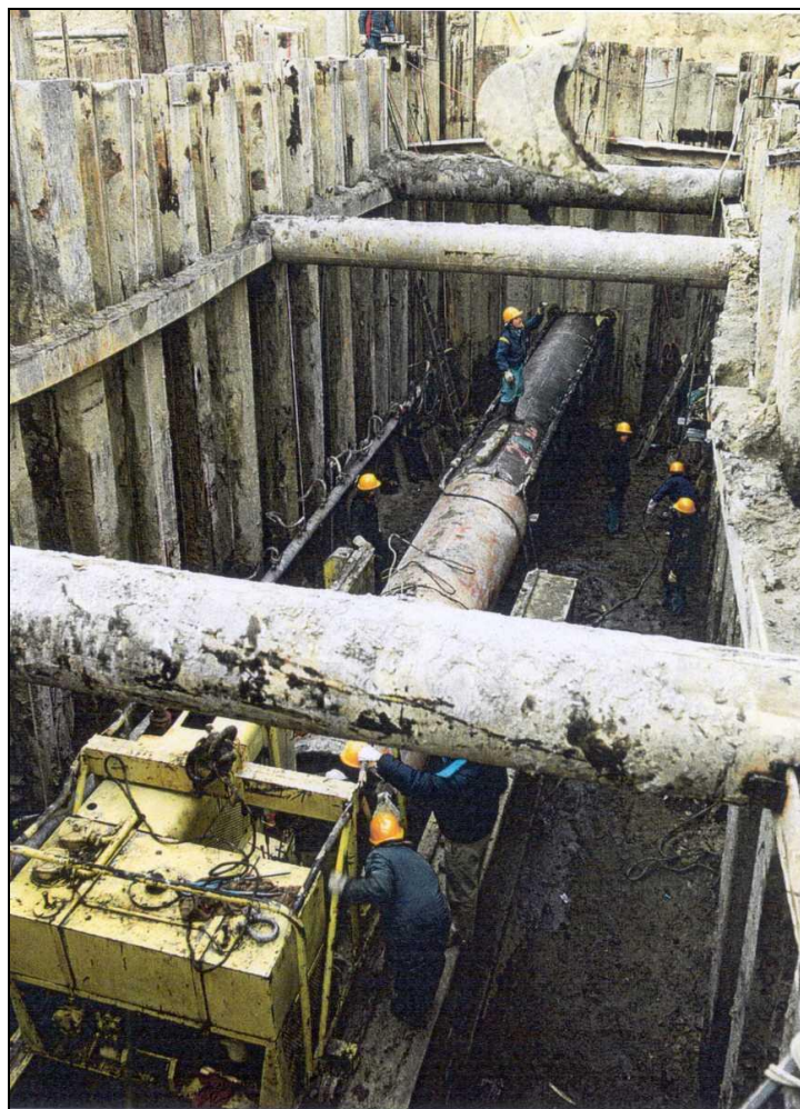
Trivellazione con spingitubo
