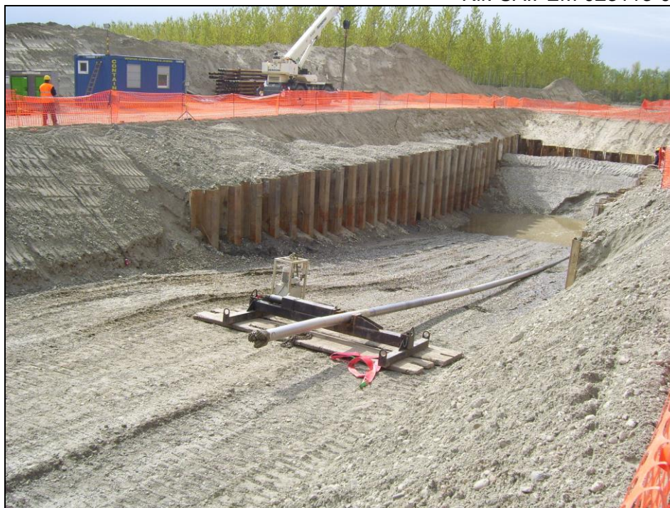
Attraversamento F. Po con met. 30" – fase di uscita dell'asta pilota
