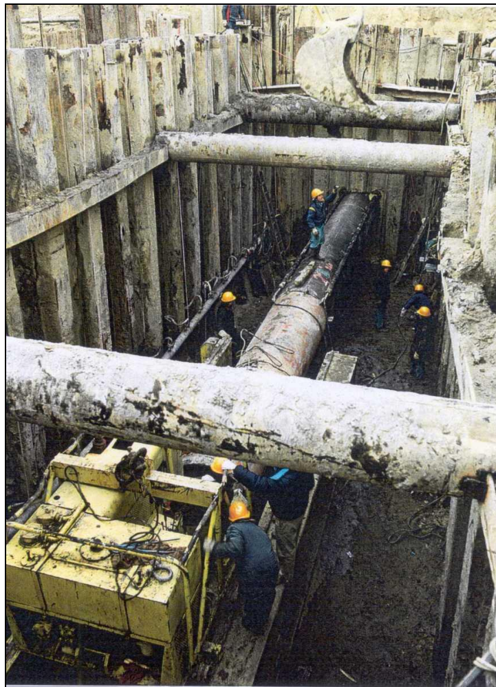
Trivellazione con spingitubo
