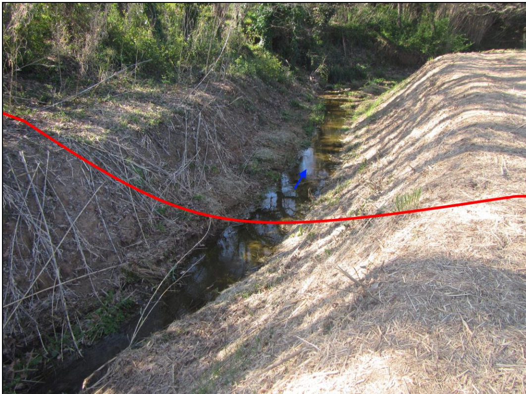
Fig.3.2/B: Foto ambito d'attraversamento
