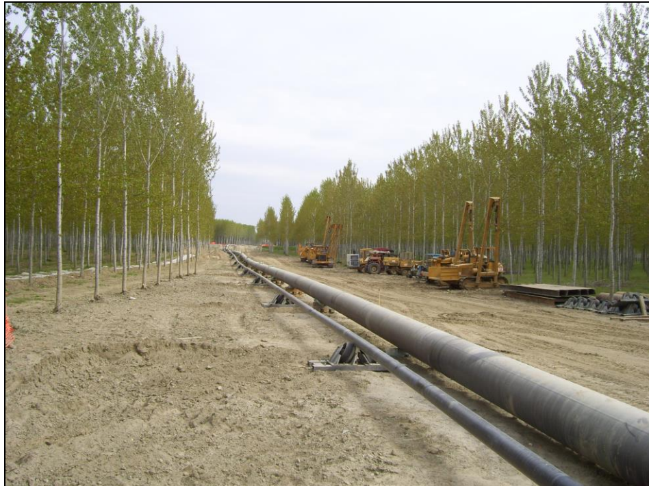
Attrav. F. Po con met. 30" – Colonna pipeline preassemblata sulla pista di varo
