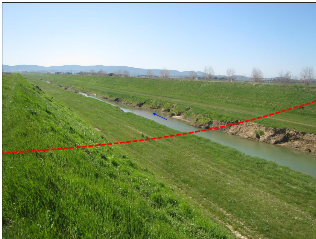
Fig.3.2/B: Foto ambito d'attraversamento
