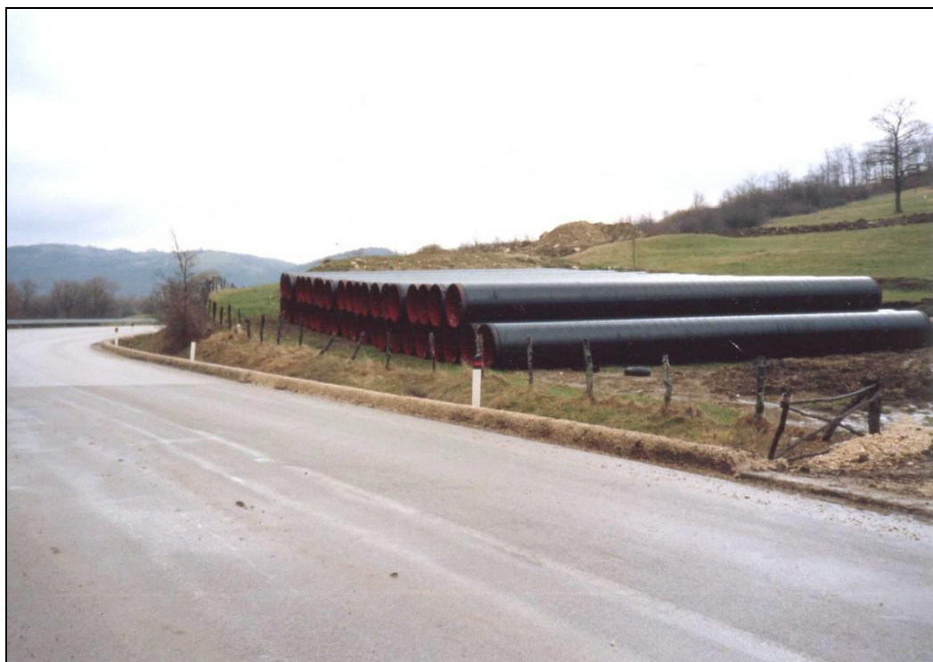
Foto 3.2/B: Esempio di piazzola di accatastamento tubazioni
