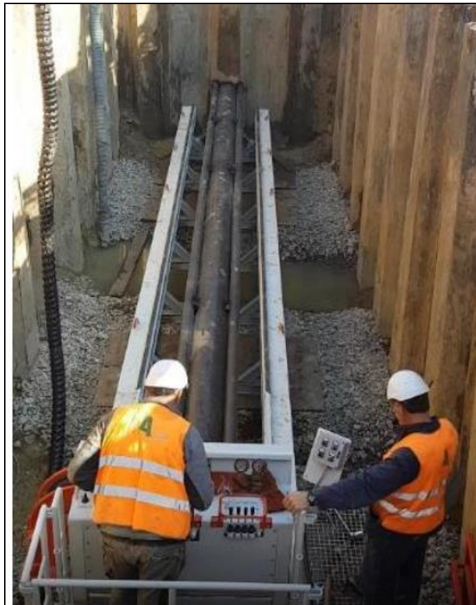
Foto 3.2/L: Trivellazione con spingitubo
