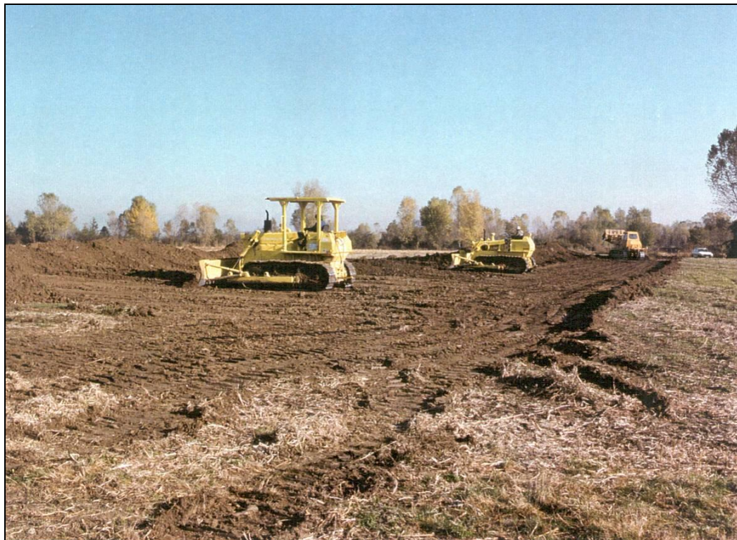
Foto 3.2/C: Apertura dell'area di passaggio
