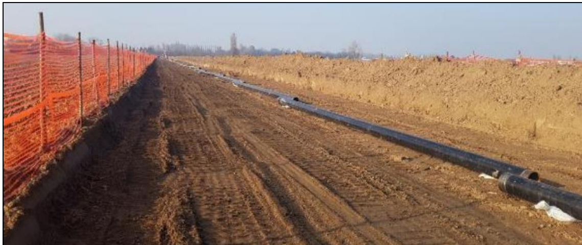
Foto 3.2/D: Sfilamento tubazioni
