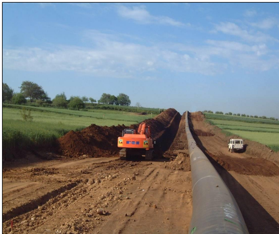
Foto 3.2/G: Scavo della trincea
