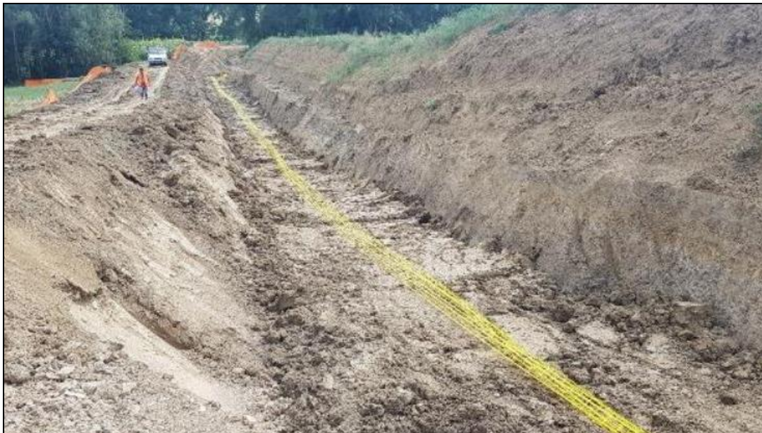
Foto 3.2/J: Rinterro della condotta
