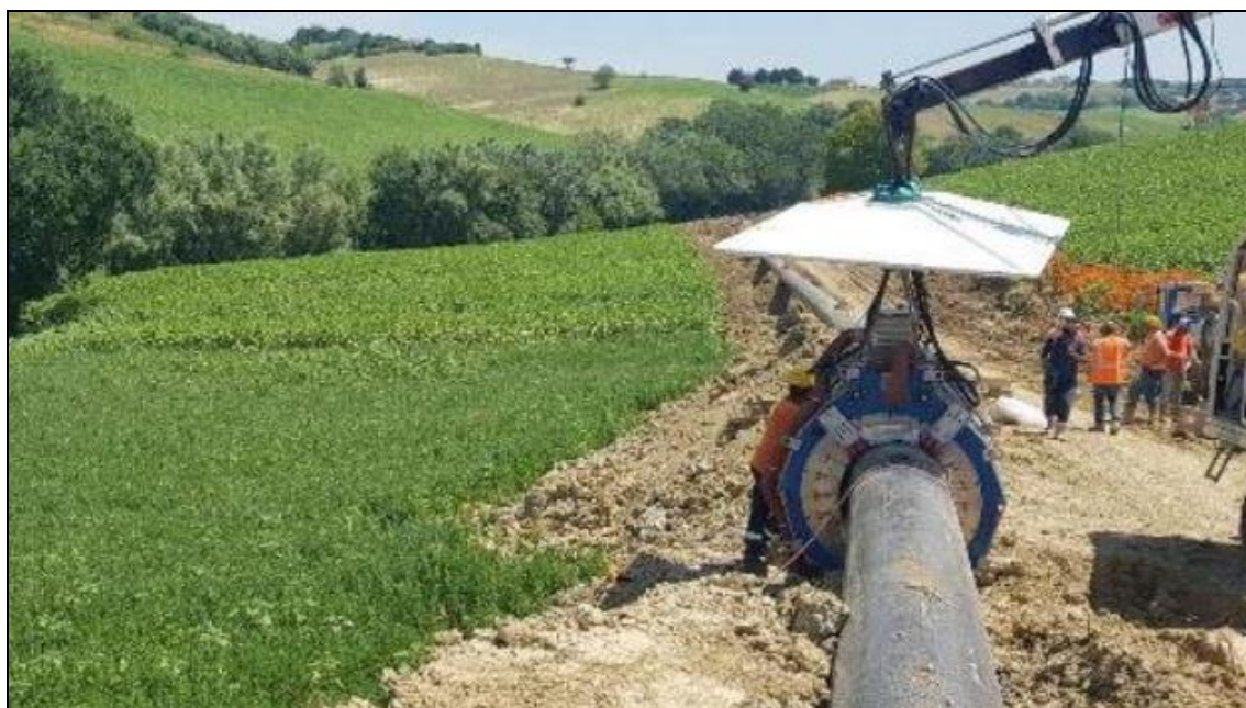
Foto 3.2/F: Esempio di saldatura automatica
