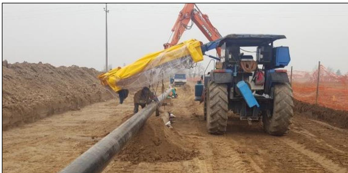
Foto 3.2/E: Esempio di saldatura manuale
