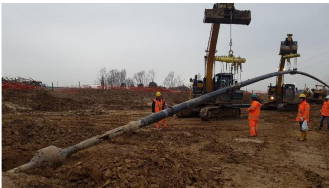
Foto 3.2/N: Esempio di operazione di varo della TOC
