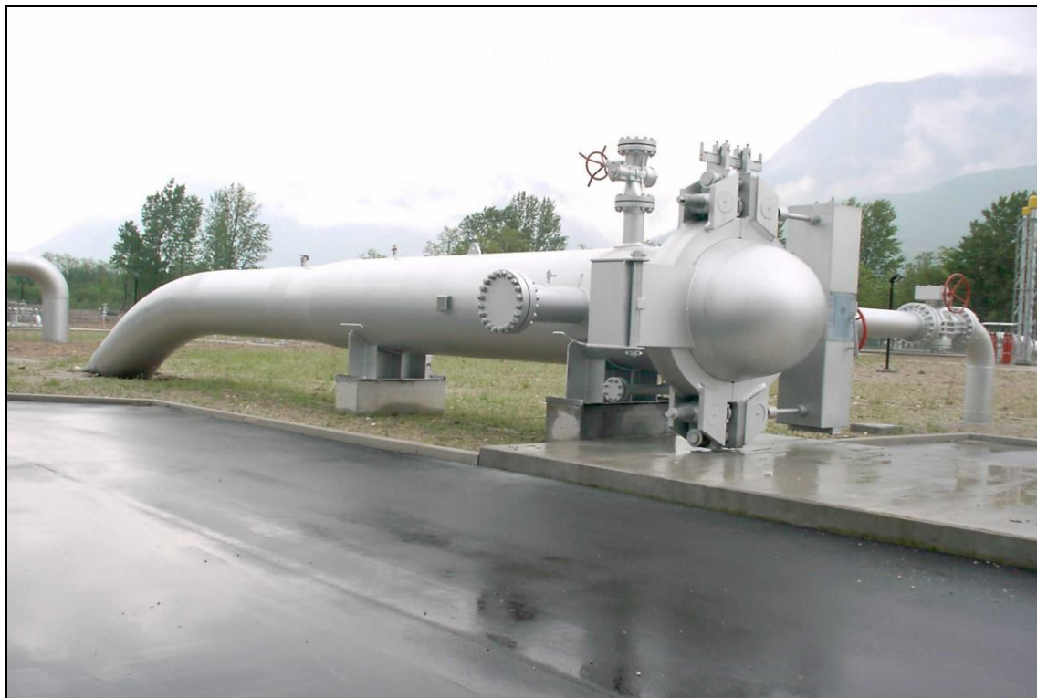
Foto 3.2/A: Punto di lancio e ricevimento pig
