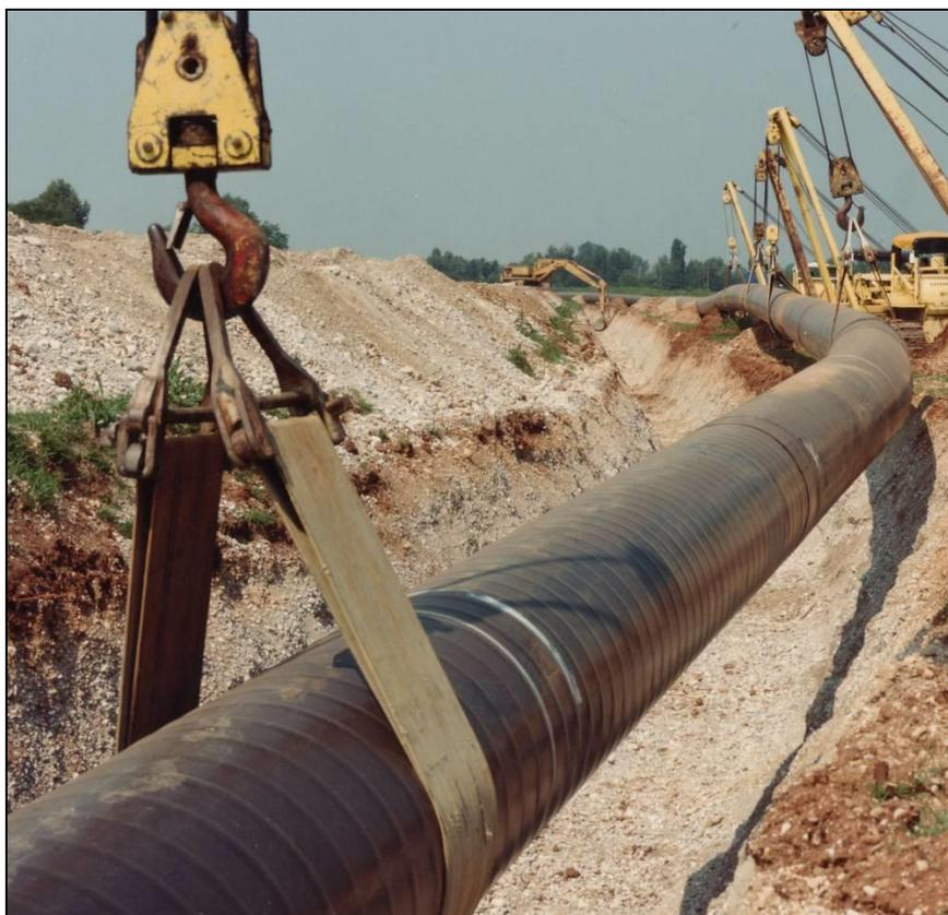
Foto 5/H: Posa della condotta (esempio di condotta con diametro superiore alla linea in progetto)
