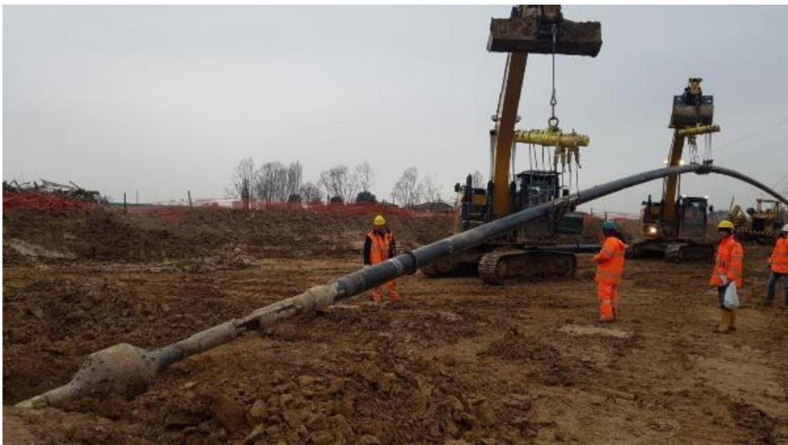
**Foto 5/P - Esempio di operazione di varo della TOC**
