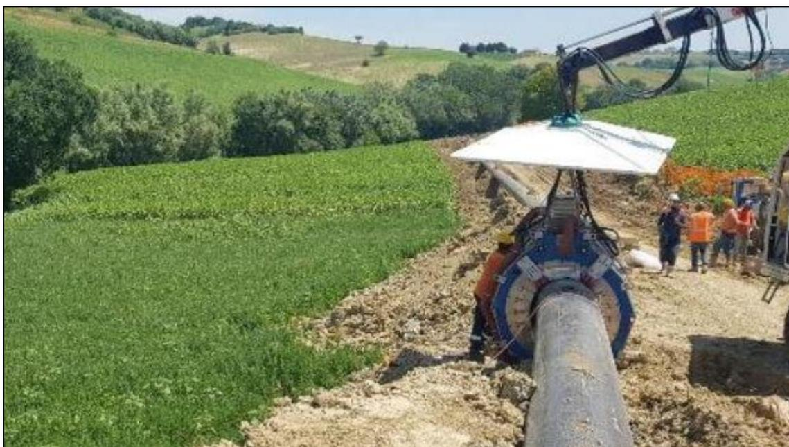
Foto 5/F: Esempio di saldatura automatica
