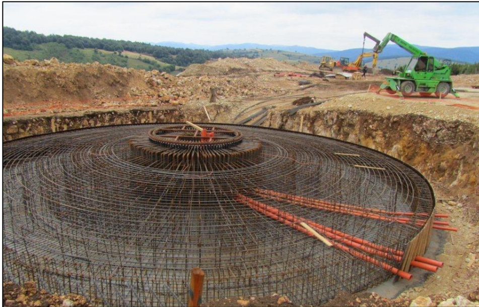
Figura 21 – Esempio di fondazione aerogeneratore in costruzione
