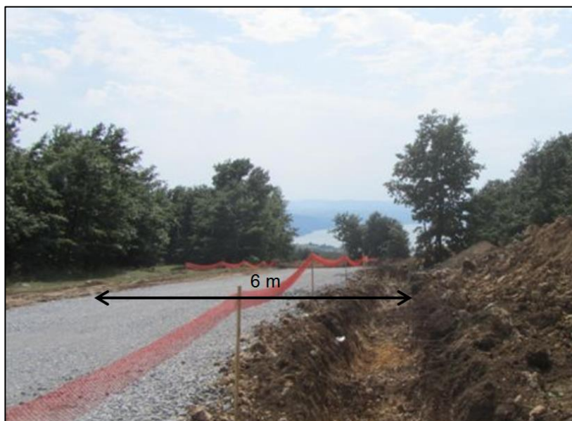
Figura 15 – Esempio di strada di impianto in costruzione con finitura in pietrischetto e trincea per cavidotto come in Figura 14
