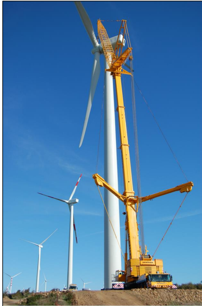
Figura 25 – Fase finale di montaggio di un aerogeneratore
