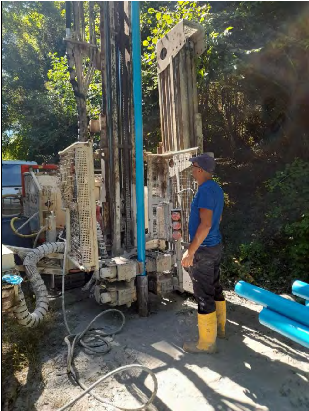
Istallazione tubo piezometrico
