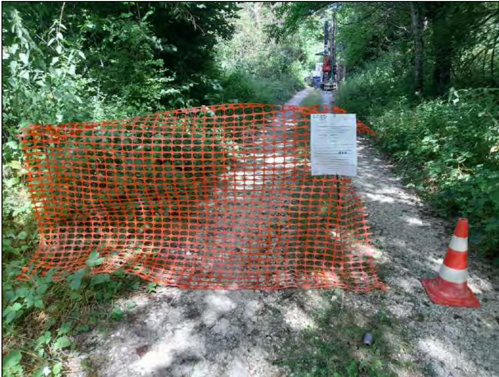
Esecuzione sondaggio geognostico a carotaggio continuo S9
