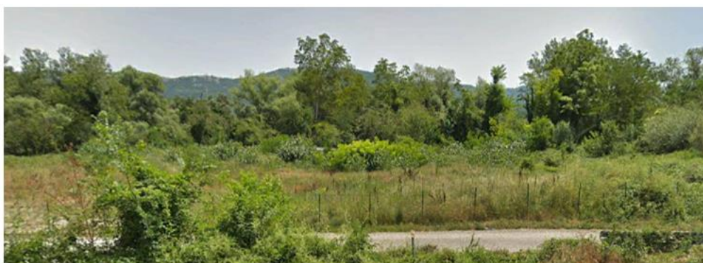
Figura 3-10 Sopra area di cantiere per il pozzo 2, con punto di vista della relativa foto inserita sotto
