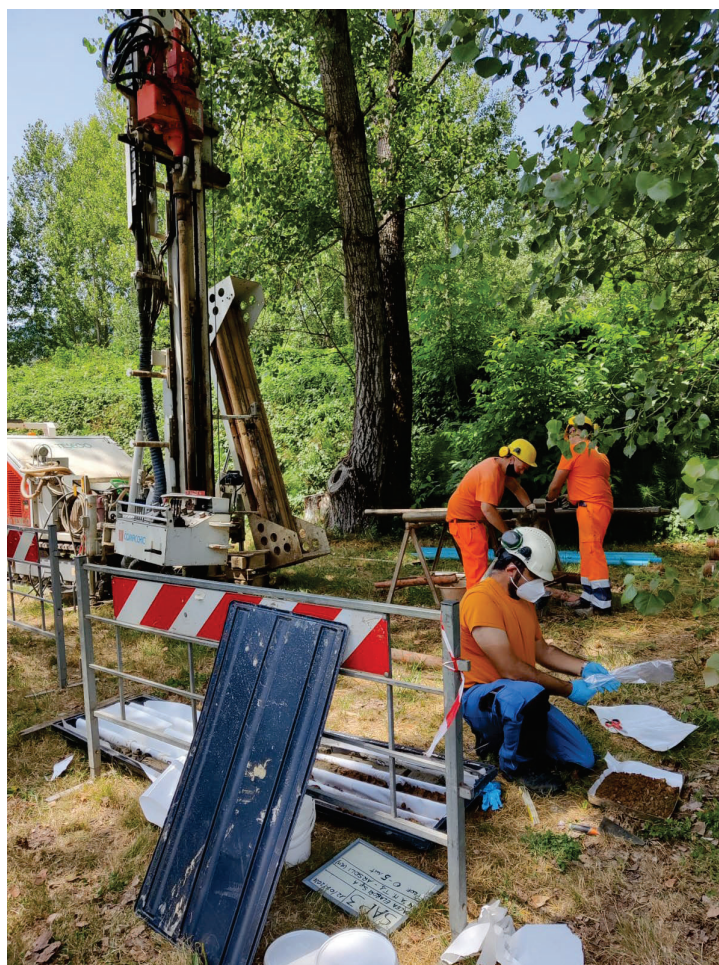
Figura 11: Foto scattata durante l’esecuzione del sondaggio SAP3.
