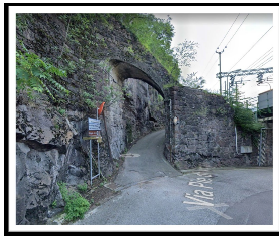
Figura 2 - Arco della funicolare del Virgolo su Via del Calvario
