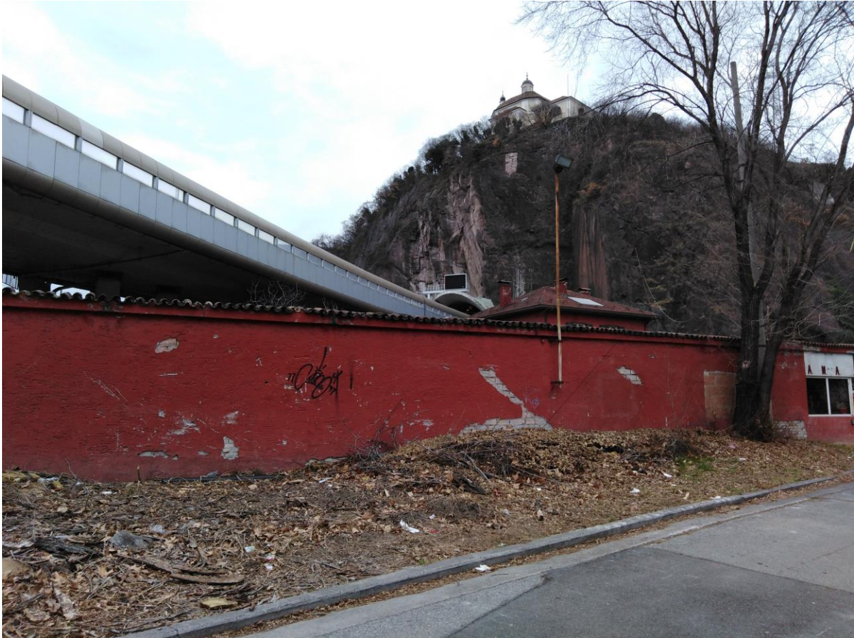
Fab-01 Muro esterno lato strada di accesso
