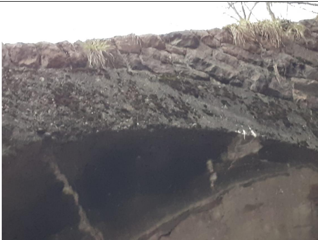
Dettaglio arco lato Nord
