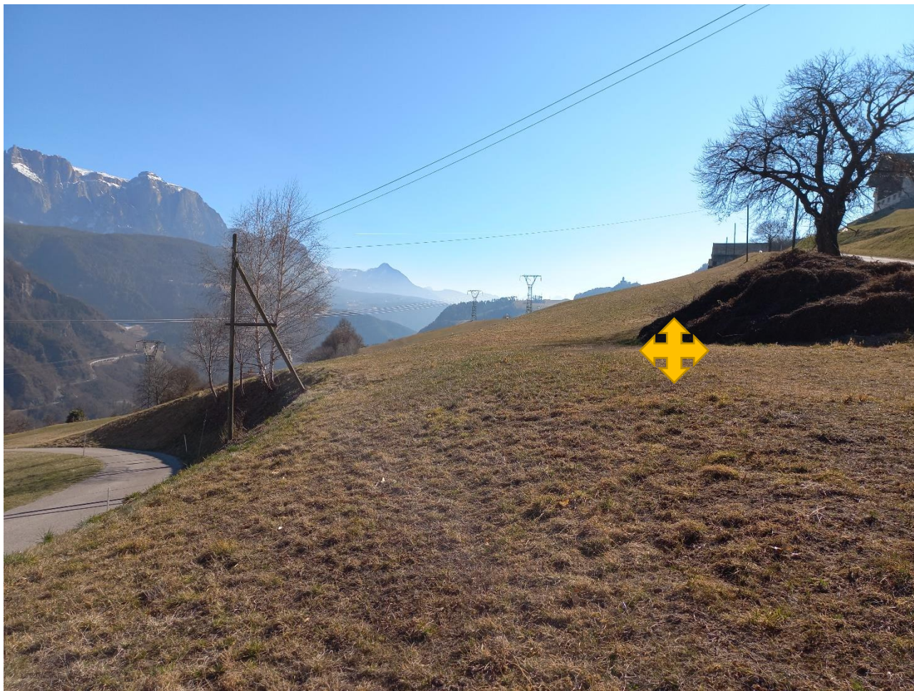
Foto 5: Posizione sostegno n. 412 DT 220/132 kV, vista verso sud
