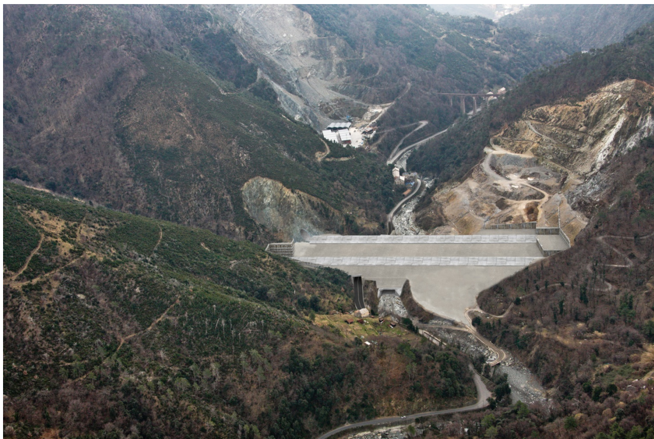
Figura 3 – Il rilevato provvisorio
