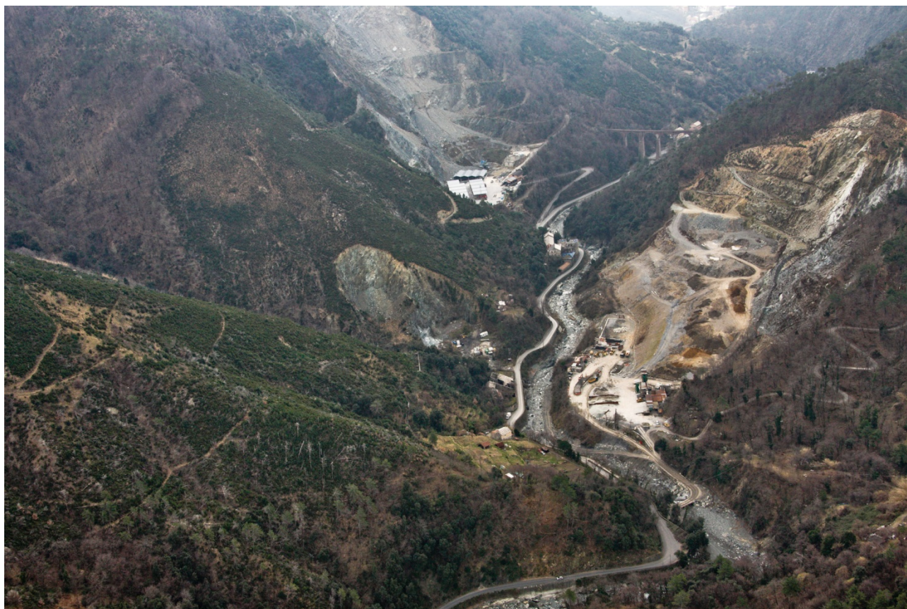
Figura 1 – La situazione esistente in corrispondenza del previsto attraversamento
