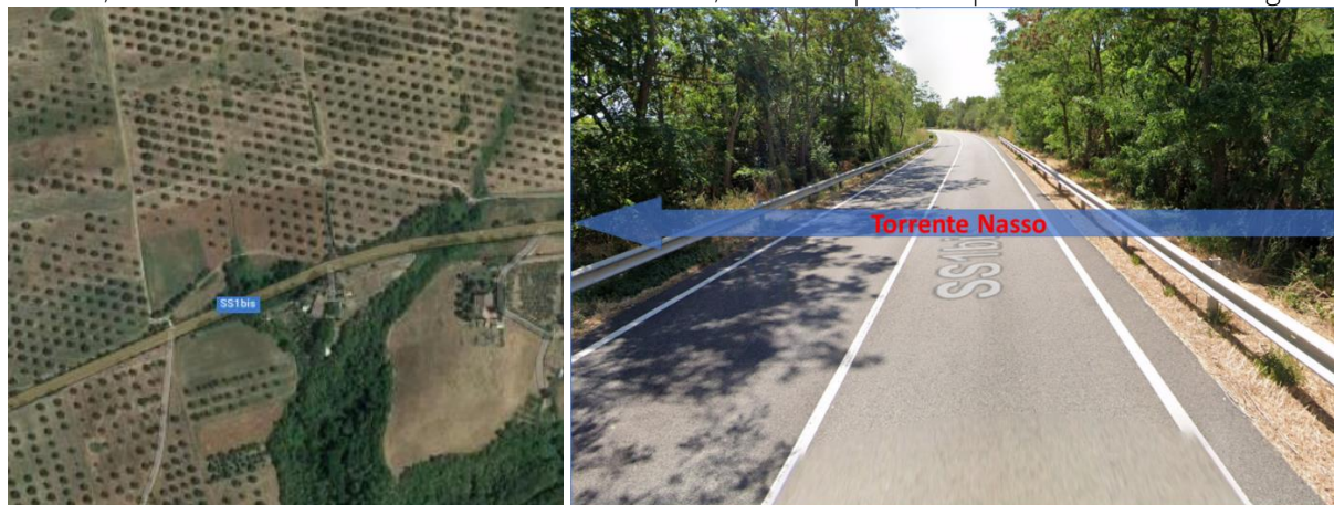
Figura 1-7 Attraversamento torrente Nasso
