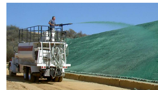
Esempio di idroseminatrice all'opera
