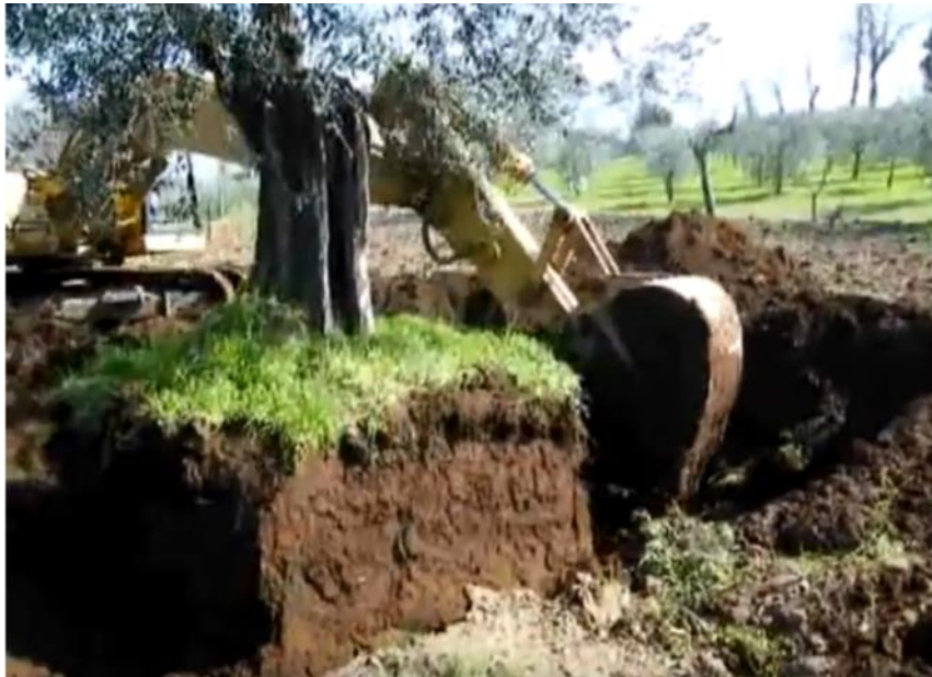
Figura 3-2 Preparazione zolla per espianto
