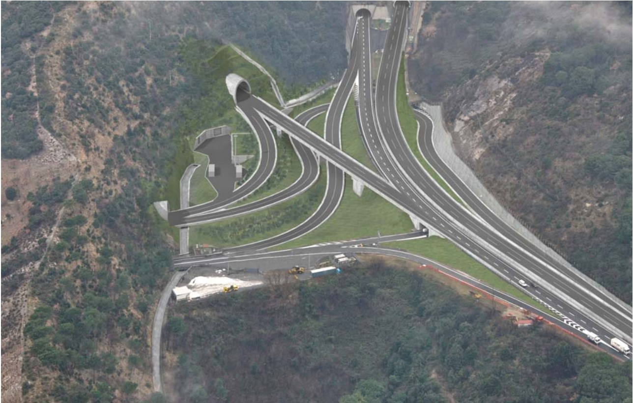
Fig. 7.1.1 – Fotosimulazione dell'area di intervento e dell'adeguamento dello svincolo di Genova Est (cfr. AUA0301-1)
