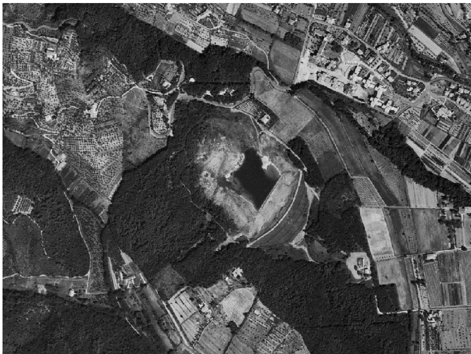
Fig. 2 - Estratti delle ortofoto scattate sopra il bacino della Giudea nel 1978 (post-operam – foto sopra) e nel 1998(post-franamento e realizzazione della tura al piede di monte dello sbarramento – foto sotto). Fonte Geoscopio – Regione Toscana
