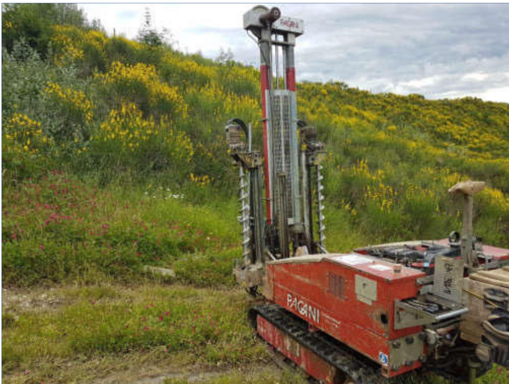
Figura 4: Prova penetrometrica CPT 4
