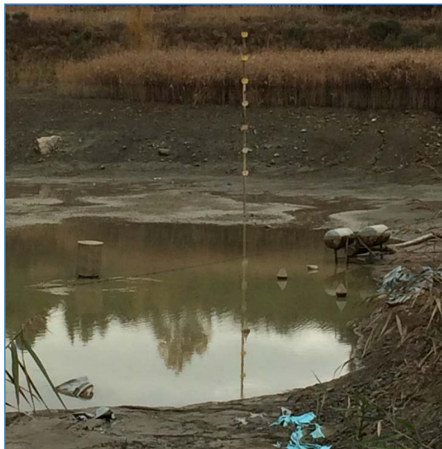
Figura 2-1: Bocca di presa dello scarico di fondo
