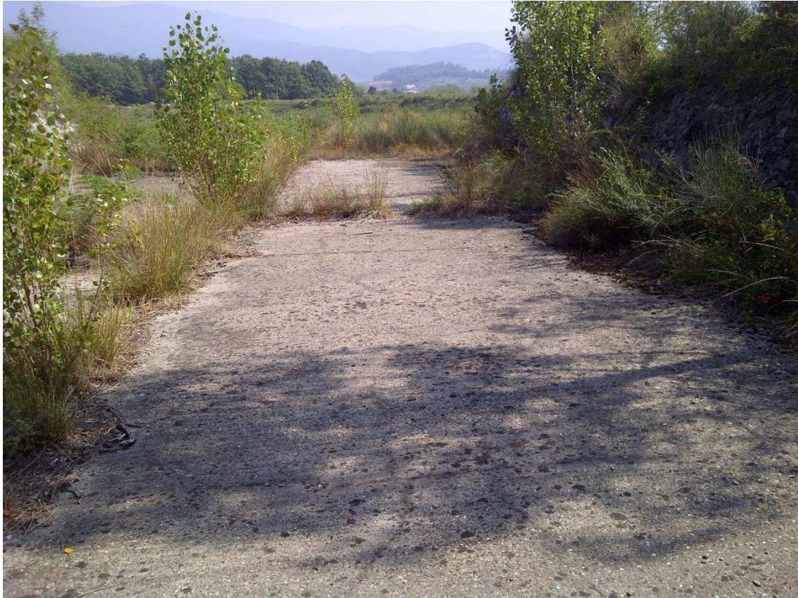
Figura 8-4: Vista canale fugatore da valle verso monte
