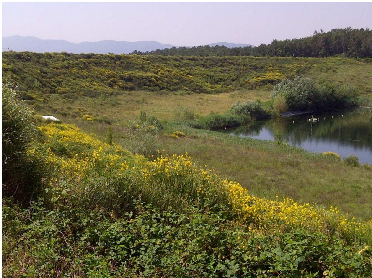
Figura 2-4: Vista dell'invaso di Gello con svaso permanente alla quota 134.5m slm..
