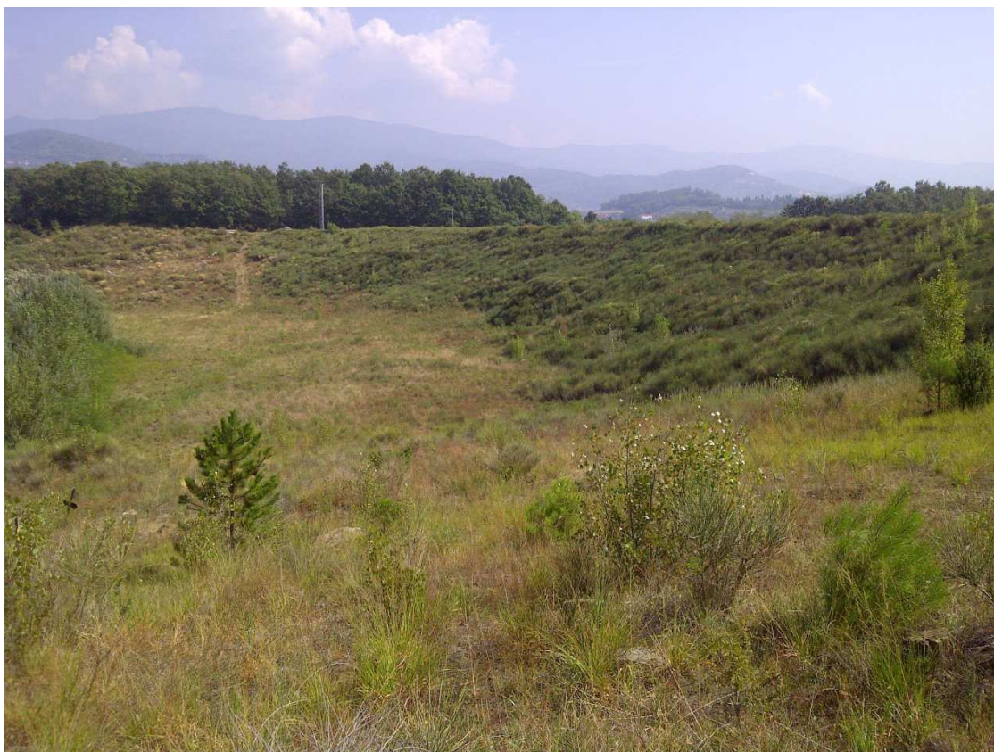
Figura 8-1: Vista dello sbarramento lato interno da sponda destra
