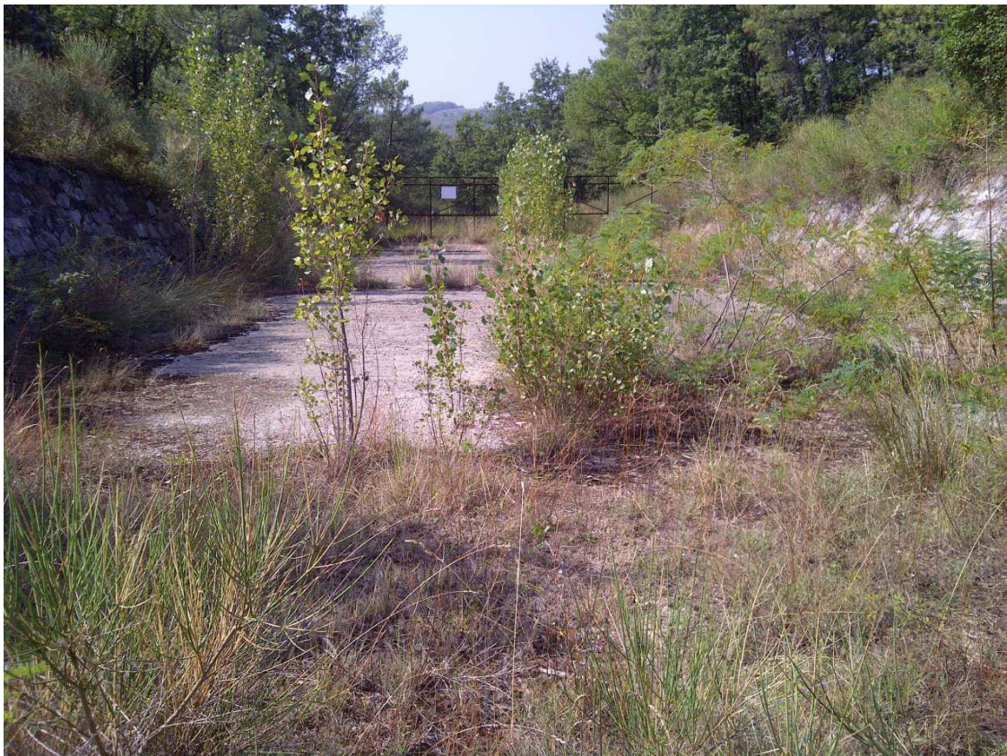
Figura 8-3: Vista canale fugatore da monte verso valle
