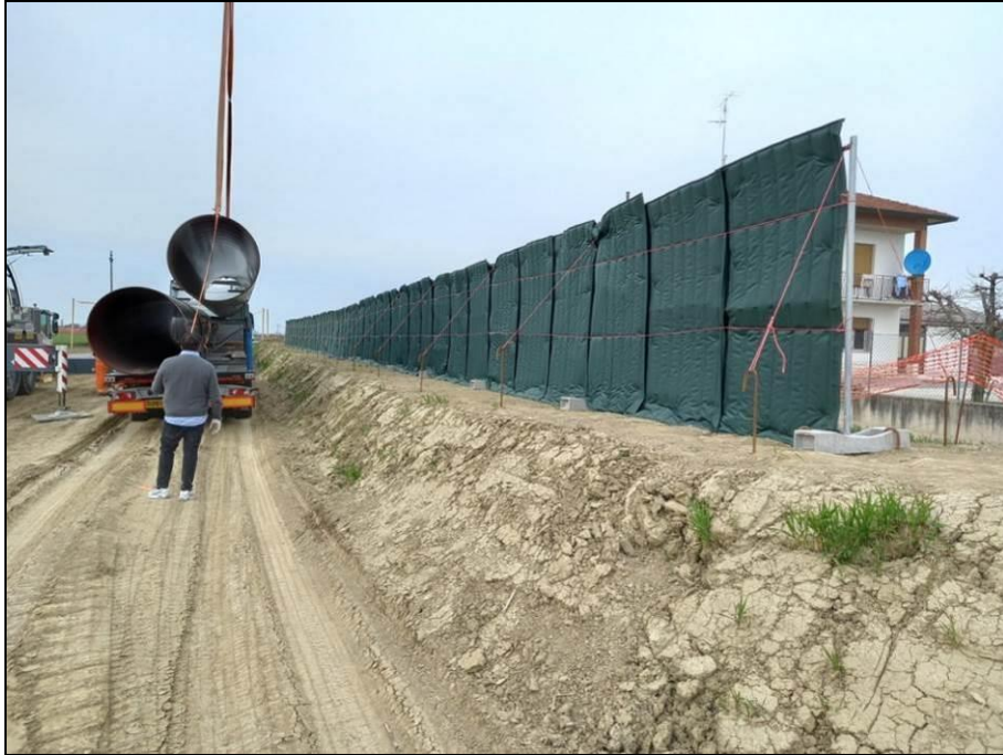
Figura 3.5.4/A - Barriera antirumore installata su rilevato in terra al P.158 della linea principale.
