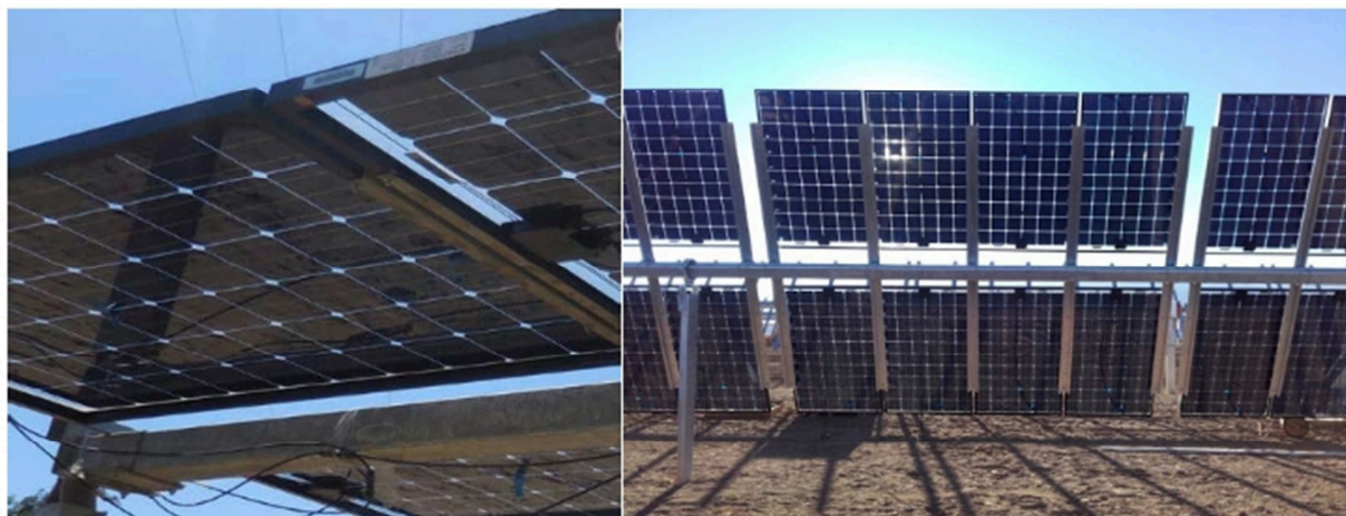
Rappresentazione indicativa struttura sostegno e moduli fotovoltaici
