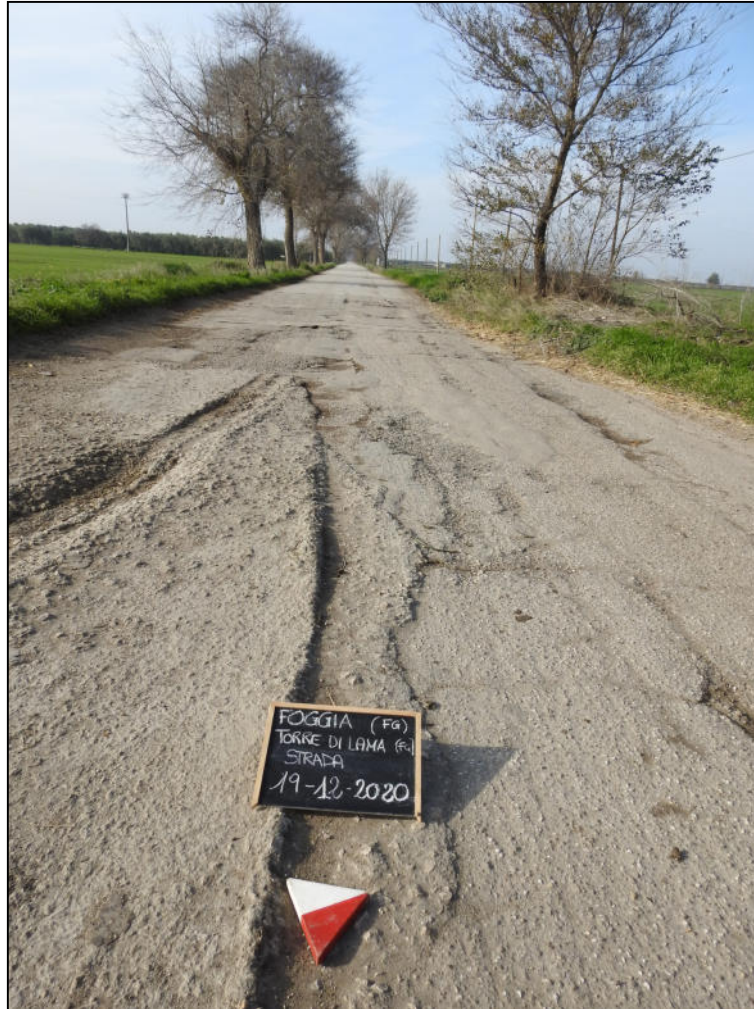
Foto 18. Torre di Lama (FG), particolare della strada asfaltata che collega il Lotto 1, ripresa da Est.
