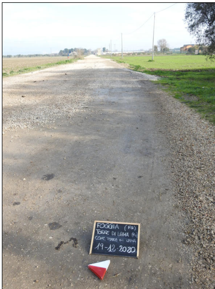
Foto 15. Torre di Lama (FG), strada interpoderale che collega il Lotto 2, ripresa da Ovest.
