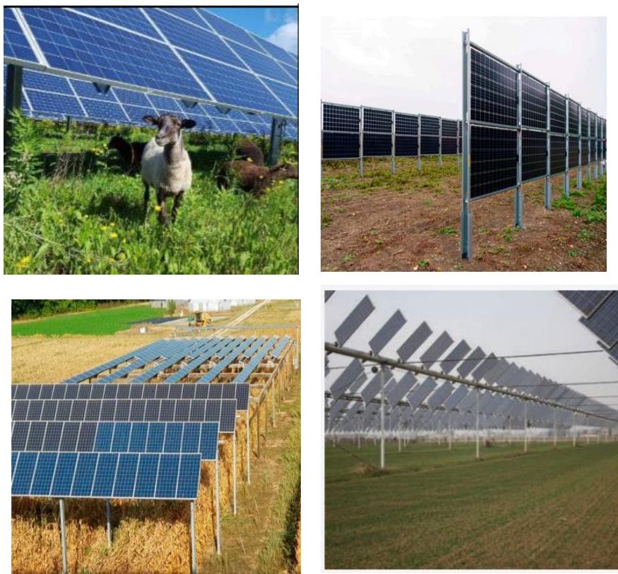
Figura 3. Soluzioni agrivoltaiche. impianti fissi (Legambiente, 2020), moduli verticali, sistemi di inseguimento (Toledo e Scognamiglio,2020), Agrovoltaico® ( https://remtec.energy/agrovoltaico ).
