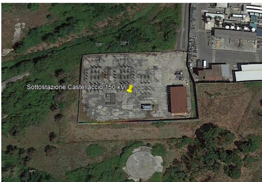
Immagine 4 – Vista della cabina primaria AT/MT "Castellaccio"
